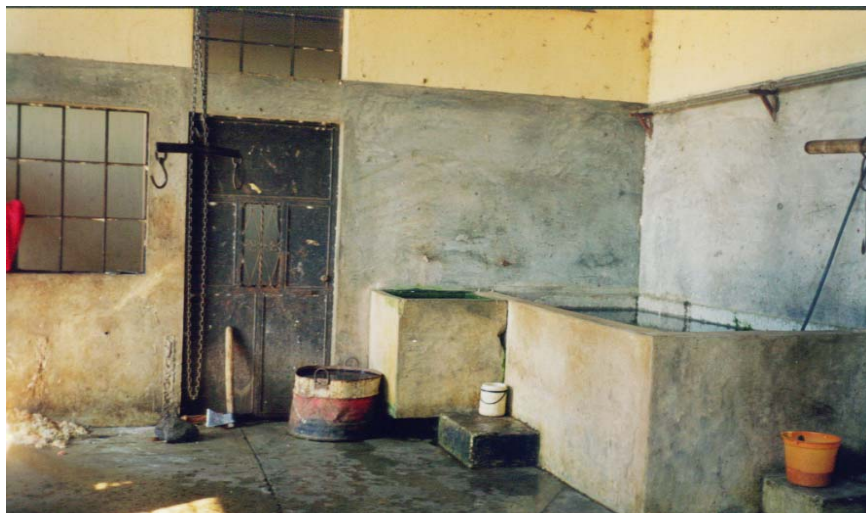
En este lavado se juntan verdes y rojas, las cuales deben ser separadas, observar utensilios de trabajo no son aptos.
