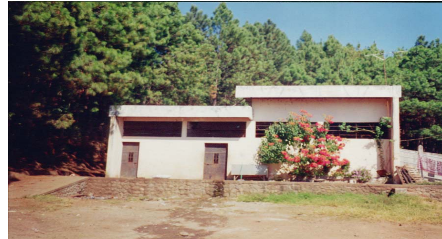
Foto No. 1 Fachada Frontal.
