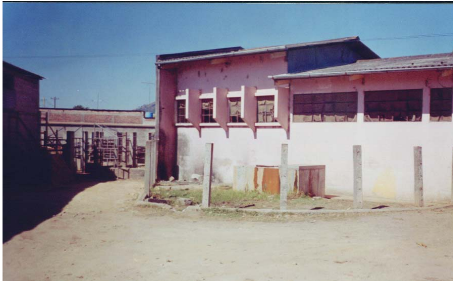
Foto No. 22 Fachada Frontal.
