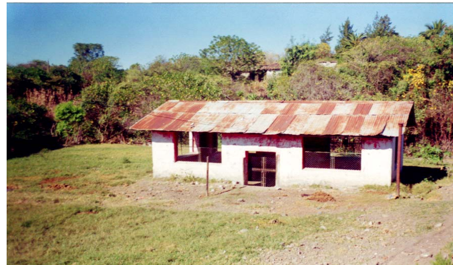
Foto No. 27 Fachada Frontal.
