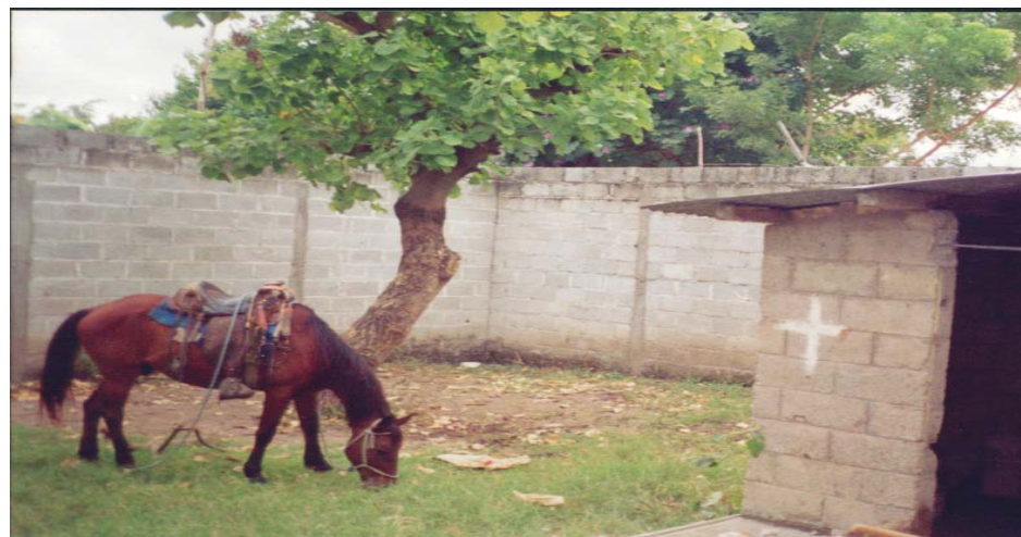
Mal ubicado y esta deteriorado.
