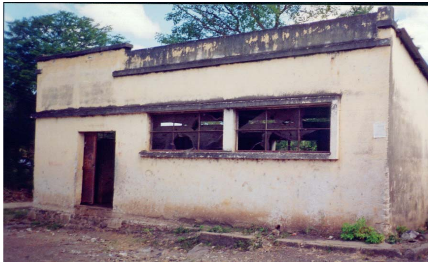
Foto No. 19 Fachada Frontal
