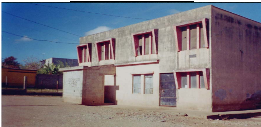
Foto No. 10 Fachada Frontal
