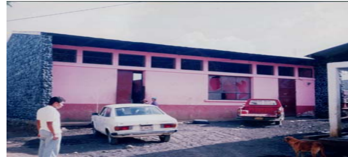
Foto No. 1 Fachada Frontal
