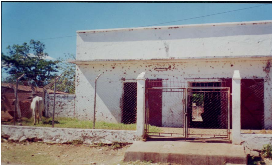
Foto No. 16 Fachada Frontal
