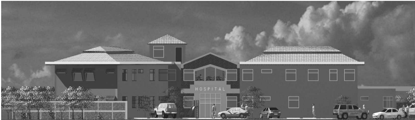
Fachada Ingreso Principal del Hospital
