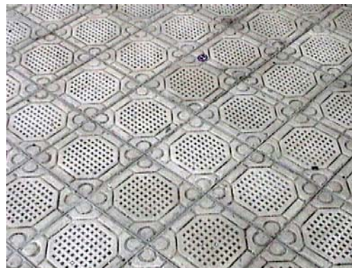
Gráfica 3-16. Piso de la lonja colocado en el año 2001. Es piso de cemento líquido, también con diseño arbitrario. Fuente: elaboración propia. Noviembre 2001.
