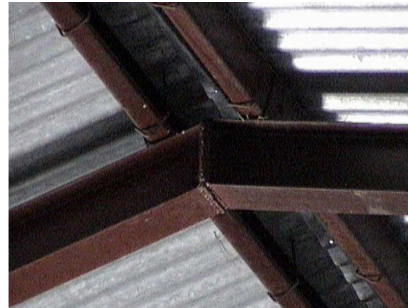
Gráfica 3-9. La cubierta de la nave está constituida por una estructura de acero y costaneras para sostener un entamado de lámina de zinc. Todo queda visto, pues no existe un cielo falso para intentar controlar el calor que emana la lámina expuesta al sol. Fuente: elaboración prpia. Noviembre 2001.
