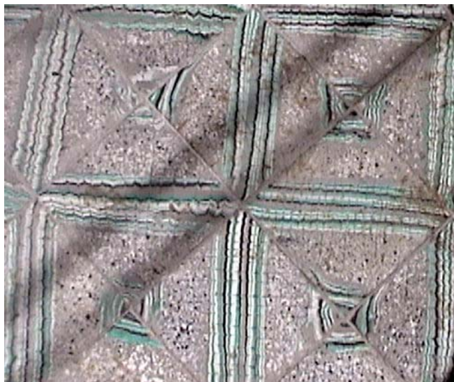
Gráfica 3-14. Textura del piso actual del Calvario. Es un piso de fabricación líquida con diseño arbitrario. Este piso resulta ser muy poco resistente al uso constante. Fuente: elaboración propia. Noviembre 2001.
