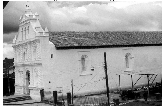
Fotografía No. 17 Iglesia
