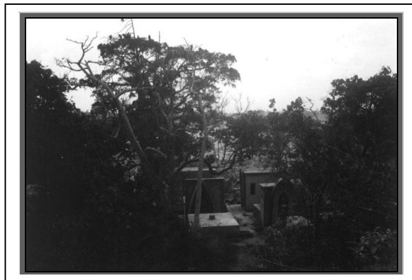
Figura 132 Cuadro 20 Habitado por aves de carroña, lo cual provoca deterioro en las tumbas por los químicos que produce la defecación de dichas aves, incluso la permanencia en el área es casi imposible.
