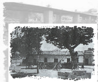
Vista antigua del Parque Plazuela la Infiesta
