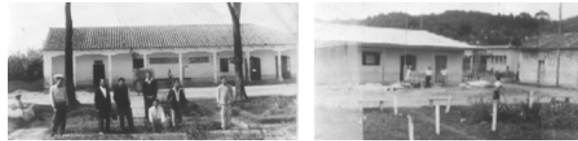
Fotografía 2 (izquierda) : data de 1930 aprox. Fachada del Edificio Municipal cuando contaba con su pórtico. (Derecha) Se observa el techo que fue sustituido por el de lámina de zinc.
