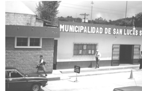
Fotografía 3: Fachada del Edificio Municipal, estado actual.
