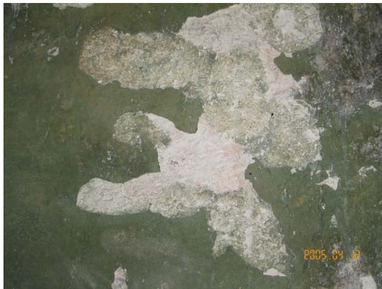
Ilustración 63 Colonias de algas, en color verdadero, edificio E, muro sur, cámara principal, elaboración propia
