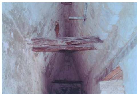
Ilustración 75 Cámara principal edificio E, obsérvese el pasador en el soffito de bóveda
