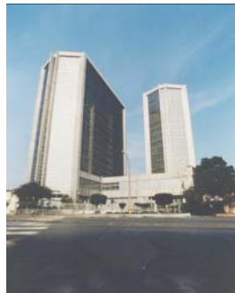
■ 2 - Torres del Banco Industrial
