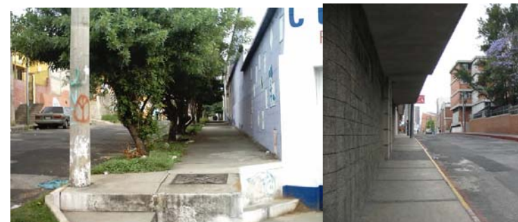
Otras poseen una serie de árboles de tamaños inadecuados, que lo que provocan es la incomodidad de los peatones al transitar sobre ellas, en casi todas las cuadras encontramos solo la banda de circulación peatonal.
