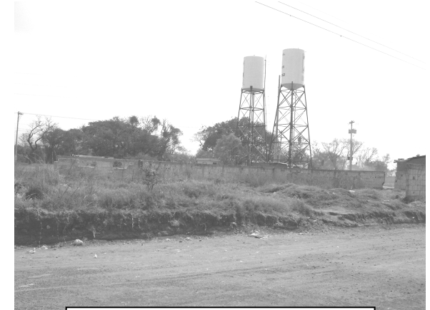
Fotografía 3 Construcción abandonada del Salón de Usos Múltiples.
