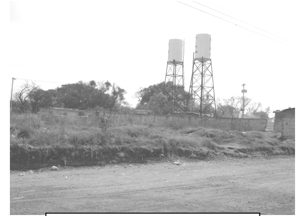
Fotografía 3 Construcción abandonada del Salón de Usos Múltiples.
