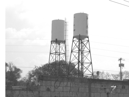
Vista de Tanques de Distribución de Agua Potable para el Asentamiento “Mario Alioto López Sánchez”, con lo cual se abastece toda la población.
