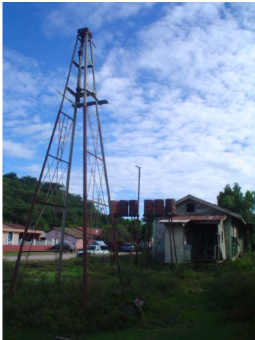
1 Foto 26. Vista Exterior de la Estación Agua Blanca. Fuente: Jorge Maldonado, Octubre 2,004
