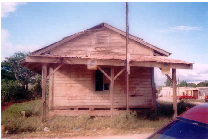
1 Foto 22. Elevación Sur Estación Agua Blanca. Fuente: Jorge Maldonado, Octubre 2,004
