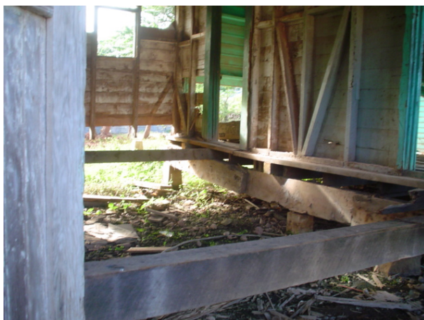
2 Foto 29. Vista Interior de la Estación Agua Blanca. Fuente: Jorge Maldonado, Octubre 2,004
