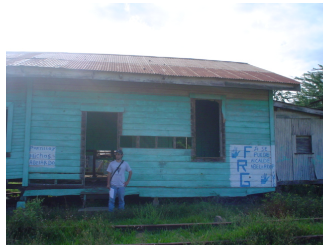
3 Foto 24. Elevación Sur Estación Agua Blanca. Fuente: Jorge Maldonado, Octubre 2,004
