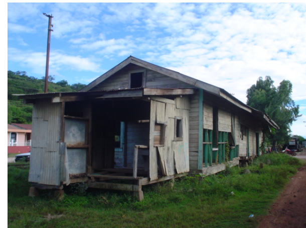
2 Foto 27. Vista Exterior de la Estación Agua Blanca. Fuente: Jorge Maldonado, Octubre 2,004
