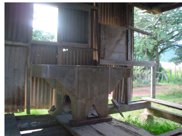
3 Foto 27. Vista Interior de la Estación Agua Blanca. Fuente: Jorge Maldonado, Octubre 2,004
