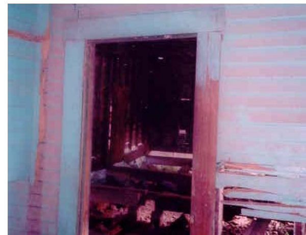
4 Foto 31. Vista Interior de la Estación Agua Blanca. Fuente: Jorge Maldonado, Octubre 2,004
