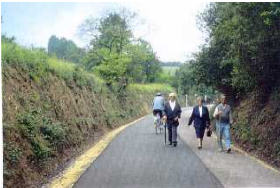
Foto.11 Diferentes tipos de superficie para los caminantes y para los ciclistas. Fuente: http://www.aevv-egwa.org/ .
