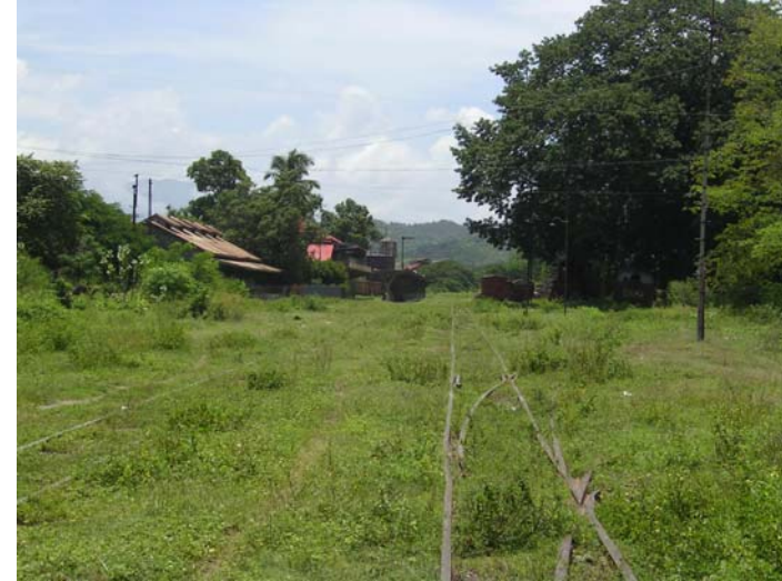
Fotografía No. 3.7. Vista de la Estación Central del Ferrocarril de Zacapa en el año 2005. Fuente: Ramírez - Torres.
