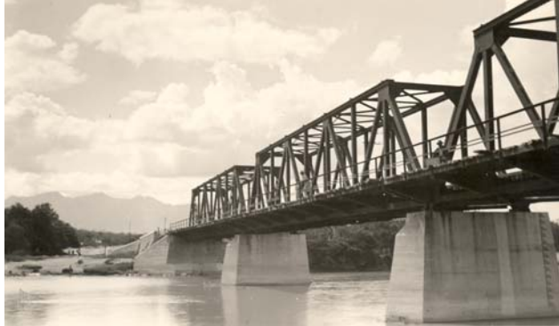
Fotografía No. 2.2, "Puente Negro", estructura de acero, ubicado sobre el Río Grande de Zacapa. Guatemala. Símbolo del Patrimonio Industrial Ferroviario. Fuente: Archivo Fotográfico de Ferrovías de Guatemala, año 1909.
