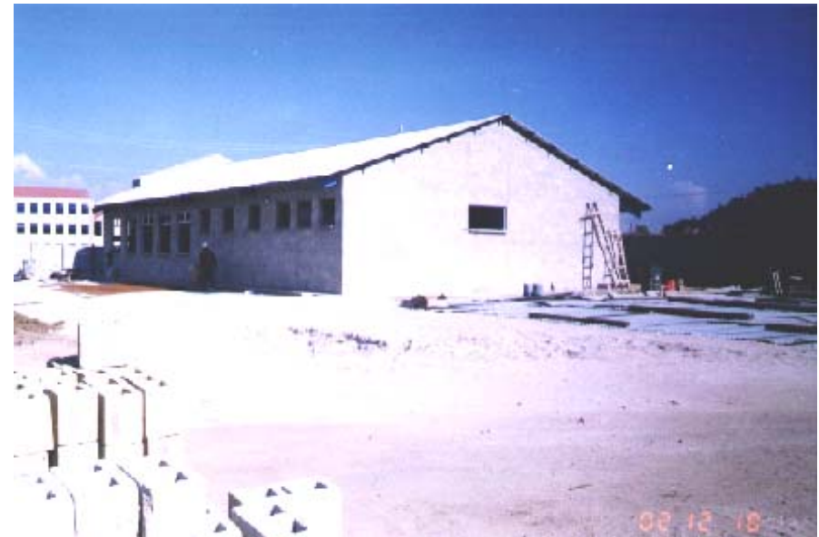
CONSTRUCCIÓN DE CLÍNICA, NODO SAN MATEO, LADO ORIENTE QUETZALTENANGO
