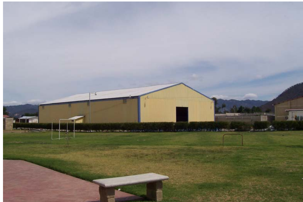
SISTEMA DE BODEGAS SAN MATEO QUETZALTENANGO
