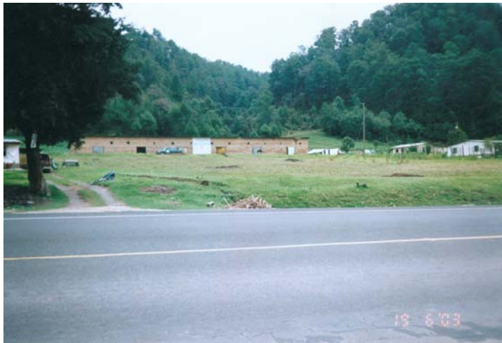
Fotografía No. 1 Terreno para la construcción del NODO INTERVIDA Santa Lucía Utatlán, Sololá.
