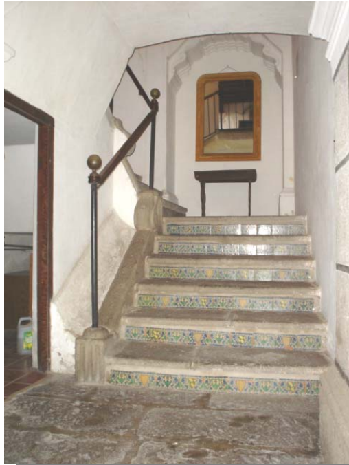
FOTOGRAFÍA 37 Integración resiente de azulejo decorado en contrahuella de gradas principales.
