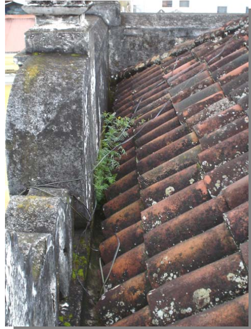
FOTOGRAFÍA 64 La acumulación de polvo y desechos en las canales provocan el crecimiento de plantas.
