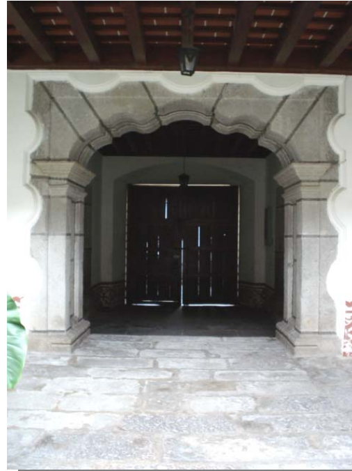
FOTOGRAFÍA 38 El piso de loseta de piedra en el ingreso principal y corredores presenta manchas por humedad.
