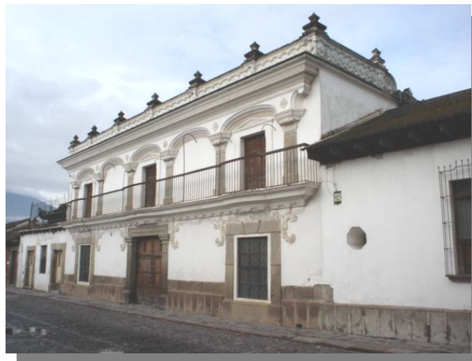
FOTOGRAFÍA 33 En la fachada de la casa no se aprecian deterioros considerables.
