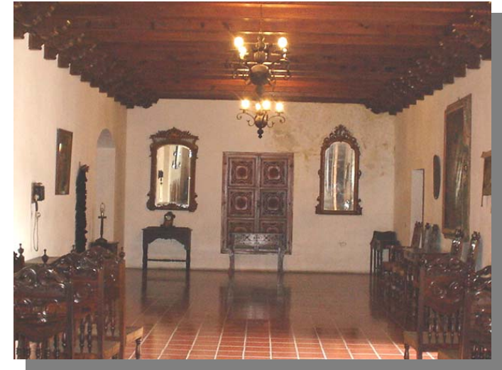
FOTOGRAFÍA 54 Los deterioros en el salón mayor son mínimos debido a la ventilación constante que recibe.
