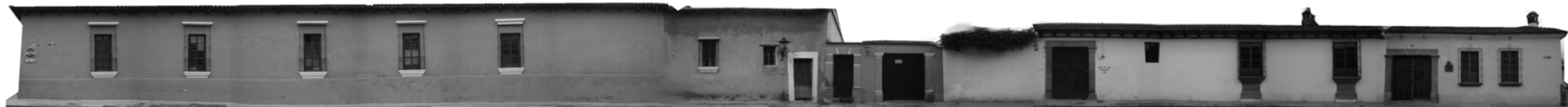
FOTOGRAFÍA 19: Vista hacia el oriente de las viviendas ubicadas en la cuadra de la 5ª avenida, entre 6ª y 7ª calles
