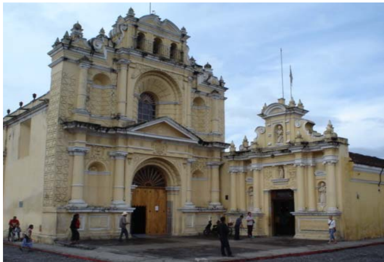
FOTOGRAFÍA 10: IGLESIA DE SAN PEDRO Levantamiento fotográfico propio
