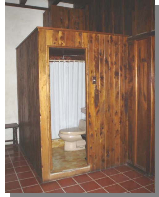
FOTOGRAFÍA 60 En la planta alta fue integrado un servicio sanitario con tabicación de duelas de madera.
