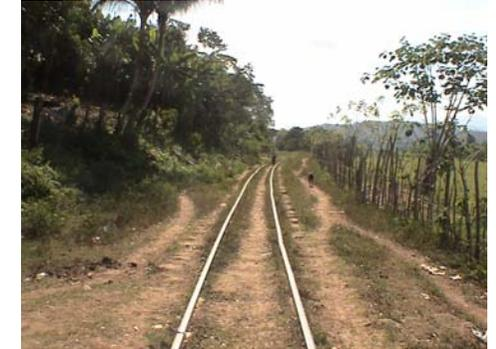
Foto No. 16 Invasión de cerco hacia el lado derecho del derecho de vía, de El Rico; hacia Santa Inés.
