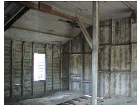
Fotos No. 108 y 109 El piso en la estación hace falta en algunos sectores, causas la falta de mantenimiento, los vidrios no existe ninguno en las ventanas habrá que reemplazarlos, los balcones en todas las ventanas se encuentran oxidados, el forro de los muros se encuentran bastante dañados, la causa mas importante es la falta de mantenimiento.
