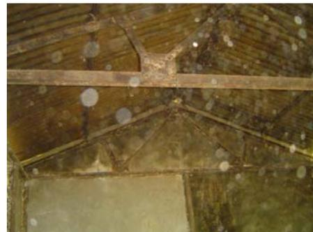
Fotos No.112 y 113 La armadura y cubierta se encuentra corroída de oxido, por falta de mantenimiento.
