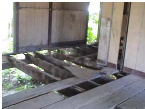
Foto No. 50 Interior Piso de la Estación, estado de deterioro muy avanzado.
