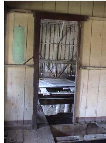
Fotos No. 86 y 87 El piso del interior de la estación en algunas partes se encuentra destruido, así como a los muros le faltan piezas al forro, también algunas viguetas de piso ya no digamos el acabado como lo es la pintura, las causas saprofitos (hongos y musgos), lluvia, humedad, falta de mantenimiento.
