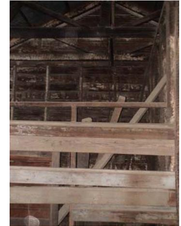
Fotos No. 96 y 97 Toda la estructura interiormente se encuentra en buen estado, aunque posee manchas y decoloración, las causas falta de mantenimiento.
