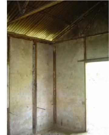
Fotos No. 116 y 117 La armadura, la cubierta, las columnas de acero "I" y los dinteles, balcones se encuentran corroídos por oxido, las causas lluvia, humedad, falta de mantenimiento, en los muros fueron hechos agujeros, en los cuales también habrá que restaurarlos.
