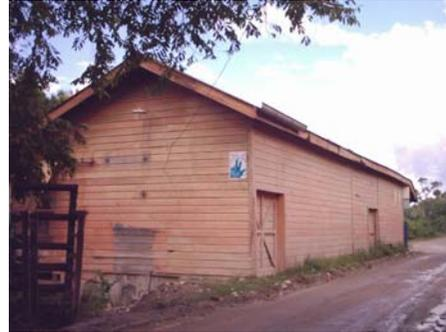
Fotos No. 90 y 91 Los muros exteriores se encuentran en muy buen estado, sobre la parte que recubre las viguetas de piso parte sur-oeste faltan algunas piezas, las causas falta de mantenimiento.
