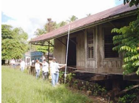
Fotos No. 80 y 81 La cubierta, los canales contienen óxido y algunas piezas de los canales hacen falta, las causas, lluvia, humedad, falta de mantenimiento, además de microflora.
