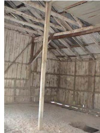
Fotos No. 106 y 107 El cielo falso se encuentra totalmente deteriorado, por causa de heterotrocios ( aves e insectos), a el forro de los muros le faltan piezas y algunas se encuentran quebradas, otras están podridas, las causas lluvia, humedad, falta de mantenimiento, las puertas ninguna de las puertas en esta estación existen, habrá que reemplazarlas.
