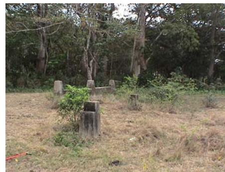
Foto No. 74 Bases de cimentación y estado actual de la Estación.
