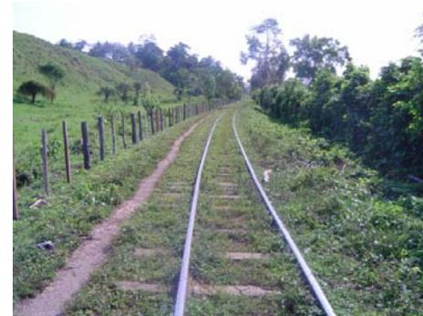
Foto No. 5 Sobre la línea férrea se observa hacia el lado izquierdo, invasión de cerco en todo el-torno, en ambos lados vegetación abundante.
