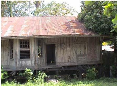
Fotos No. 82 y 83 Los muros, marcos de ventanas y puertas tienen problemas de desgaste, manchas, humedad, desgaste las causas lluvia, falta de mantenimiento.
