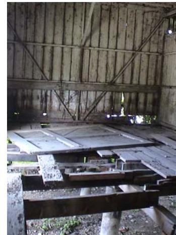
Fotos No. 88 y 89 Las puertas que todavía existen se encuentran desinstaladas tiradas sobre el piso y en mal estado, faltan viguetas de piso y piezas de la duela del piso, faltan piezas que cubren los muro, las causas lluvia, humedad, falta de mantenimiento, saprofitos (hongos y musgos).
