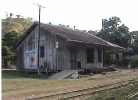
Fotos No.102 y 103 La cubierta así como los canales de encuentran totalmente oxidados de lado externo, así como que también faltan piezas de las canales, las causas humedad, lluvia, falta de mantenimiento.
