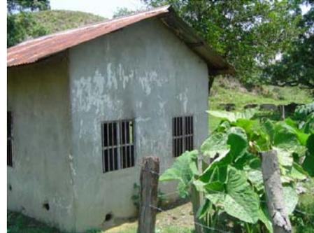
Fotos No. 110 y 111 Los muros entre los deterioros que poseen se encuentran, manchas, humedad, microflora, y manchas; las causas son saprofitos, lluvia, falta de mantenimiento y humedad.
