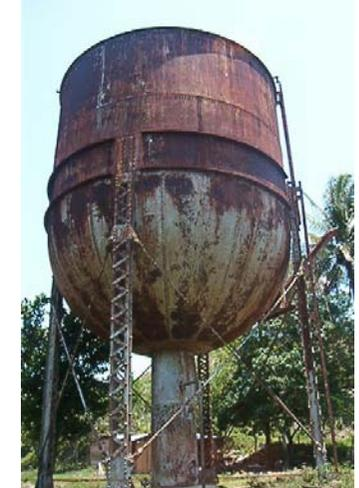
Fotos No. 118 y 119 La lamina, la estructura de la bomba, como lo son las columnas de acero, sus tensores, escaleras, la base central; se encuentran totalmente corroídas de oxido, las causas son saprofitos (hongos y musgos, lluvia, humedad y falta de mantenimiento).
