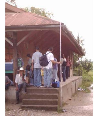
Fotos No. 98 y 99 La cubierta y canales se encuentran con mucho oxido y faltan algunas piezas en los canales, el andén de concreto tiene desgastes así como las gradas, producto de la falta de mantenimiento, a las columnas exteriores habrá que darles una aplicación de acabado es decir pintura, porque no poseen.
