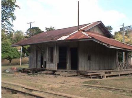
Fotos No. 100 y 101 El andén se encuentra totalmente destruido desde el piso hasta las viguetas de piso, así como también las gradas, las causas lluvia, humedad, saprofitos, falta de mantenimiento.
