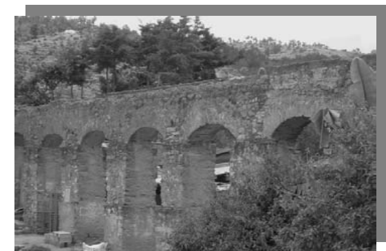
Foto No. 20 Acueducto parte de la arquitectura del siglo XVIII en Tejutla. Autor: Propia.
