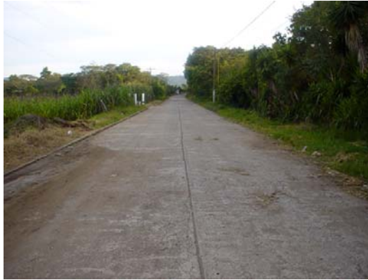
En esta imagen podemos observar la vía de acceso principal al proyecto, la cual viene de la cabecera municipal de Santa Cruz Naranjo a 1 Km. de distancia.
