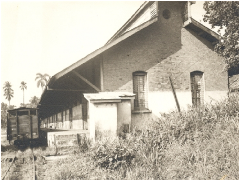
Foto 3: Bodega de carga de la Estación Escuintla, Milla 245. Fuente: Carlos Torres
