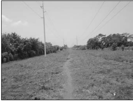
FOTO 37: EN LA FOTOGRAFÍA SE APRECIA EL DERECHO DE VÍA EL CUAL LO UTILIZAN COMO CAMINO PEATONAL PARA COMUNICARSE ENTRE LAS FINCAS Y PARA EL PASO DE GANADO, EN ESTA ÁREA YA NO EXISTEN LOS RIELES NI LOS DURMIENTES QUE COMPOÑIAN LA LÍNEA DEL FERROCARRIL, ES UN ÁREA CON MUY Poca SOMBRA COMO SE PUEDE APRECIAR EN LA FOTOGRAFÍA, ES BASTANTE PLANO, EL DERECHO DE VÍA ESTÁ DELIMITADO POR CERCOS.(FUENTE JUAN MEJICANOS Y JORGE XIQUÍN)
