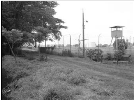
FOTO 43: EN LA FOTOGRAFÍA SE APRECIA CLARAMENTE EL DERECHO DE VÍA QUE SE ENCUENTRA SIN NINGUN DURMIENTE COMO SIN LOS RIELES, ESTE ANTES LO UTILIZARON COMO CAMINO, POR LA RODADA CIRCULAN VEHICULOS.(FUENTE JUAN MEJICANOS Y JORGE XIQUÍN)
