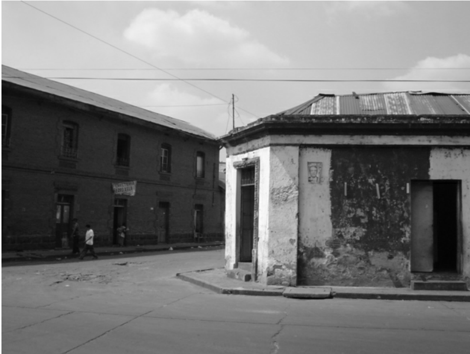
Foto 5: Se puede observar los edificios contemporáneos a la construcción de los edificios de la estación del Ferrocarril que anteriormente eran hoteles, El Gran Hotel Del Ferrocarril. Fuente: elaboración propia.
