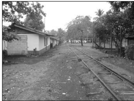
FOTO 32: SE APRECIA LA CONSERVACIÓN DE LA ESTRUCTURA DE LA LÍNEA FERREA COMO LA DELIMITACIÓN DEL DERECHO DE VÍA, EN ESTA ÁREA NO INVADIERON YA QUE SE ENCONTRABA HABITADA, ENCONTRÁNDOSE 16 FAMILIAS LOS CUALES ALGUN MIEMBRO DE LAS FAMILIAS FUE LABORANTE DE FEGUA, LLAMADA MOTORIZADA DESDE LA EPOCA DEL FERROCARRIL Y ASÍ CONSERVAN EL NOMBRE, ESTÁ LOCALIZADA ENTRE LA MILLA 246 Y 247 POSTES DEL 1 AL 3 (FUENTE JUAN MEJICANOS Y JORGE XIQUÍN)
