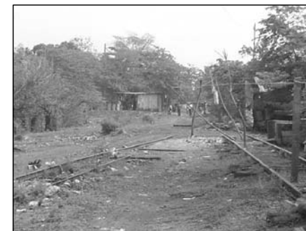
FOTO 35: EN ESTA FOTOGRAFIA SE APRECIA UNA ESPUELA QUE PARCIALMENTE LA HAN DESTRUIDO, ÉSTA TAMBIÉN ES DEL ASENTAMIENTO NÚMERO UNO, EN ESTA INVACIÓN NO SE PUDO ESTABLECER EL NÚMERO EXACTO DE FAMILIAS YA QUE AÚN NO ESTABAN ESTABLECIDAS. (FUENTE JUAN MEJICANOS Y JORGE XIQUÍN)
