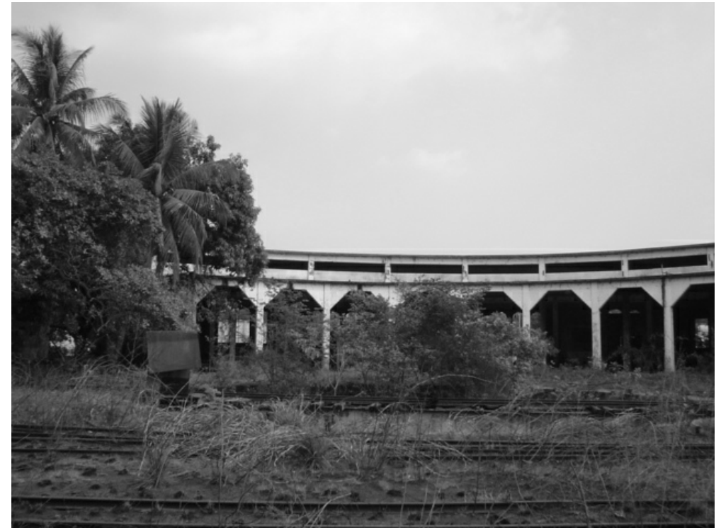
Foto 9: En la fotografía se puede apreciar la casa redonda después del año 1,900 y como está en la actualidad. Fuente Juan Mejicanos y Jorge Xiquin (abril 2004)
