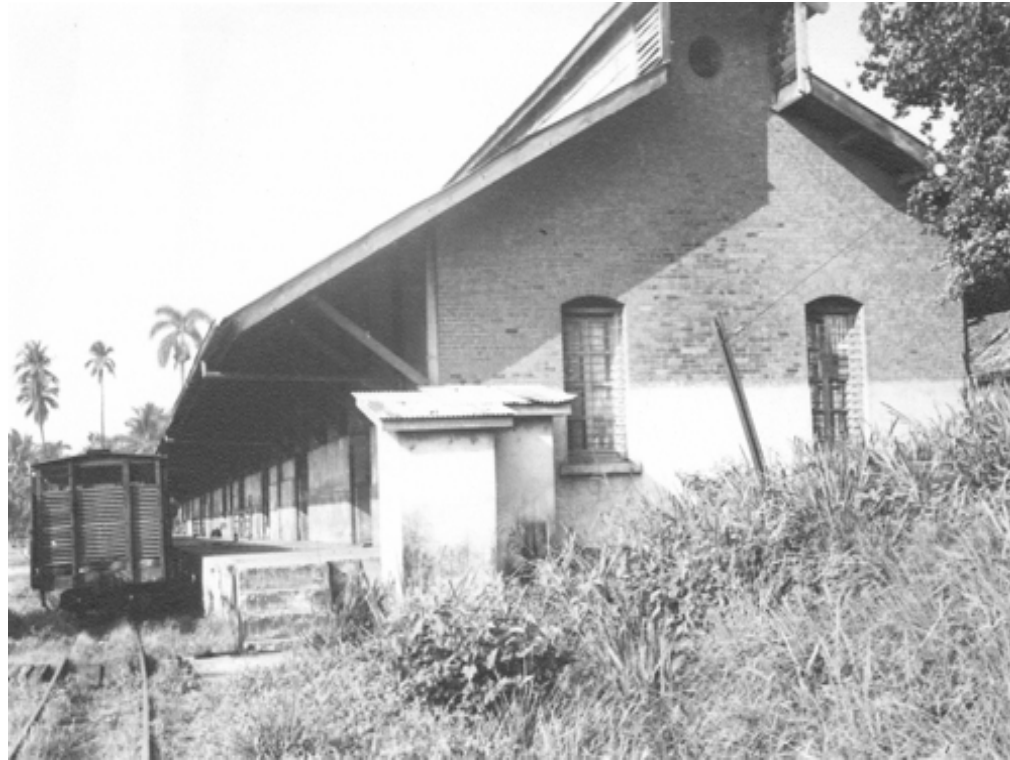
Foto 10: En la fotografía se puede observar el cleristorio en la parte superior como el rosetón, que se encuentra de norte a sur. Esta fotografía data del año 1,900 Fuente Anacafe.
