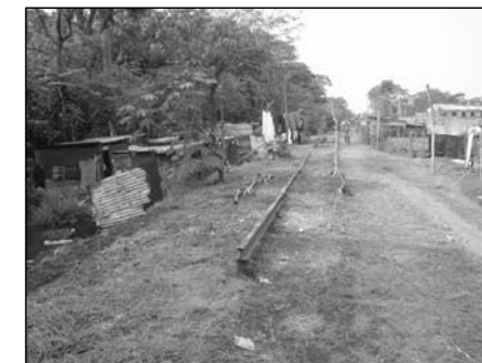
FOTO 36: EN LA FOTOGRAFIA SE APRECIA COMO ESTÁ LA VÍA, PARCIALMENTE SE HAN LLEVADO GRAN PARTE DE LOS RIELES, ESTA INVACIÓN TAMBIÉN ES DE RECIENTE OCUPACIÓN POR ESE MOTIVO TAMBIÉN NO SE TIENE EL DATO DE LA CANTIDAD DE FAMILIAS QUE LA OCUPARÁN (FUENTE JUAN MEJICANOS Y JORGE XIQUÍN)
