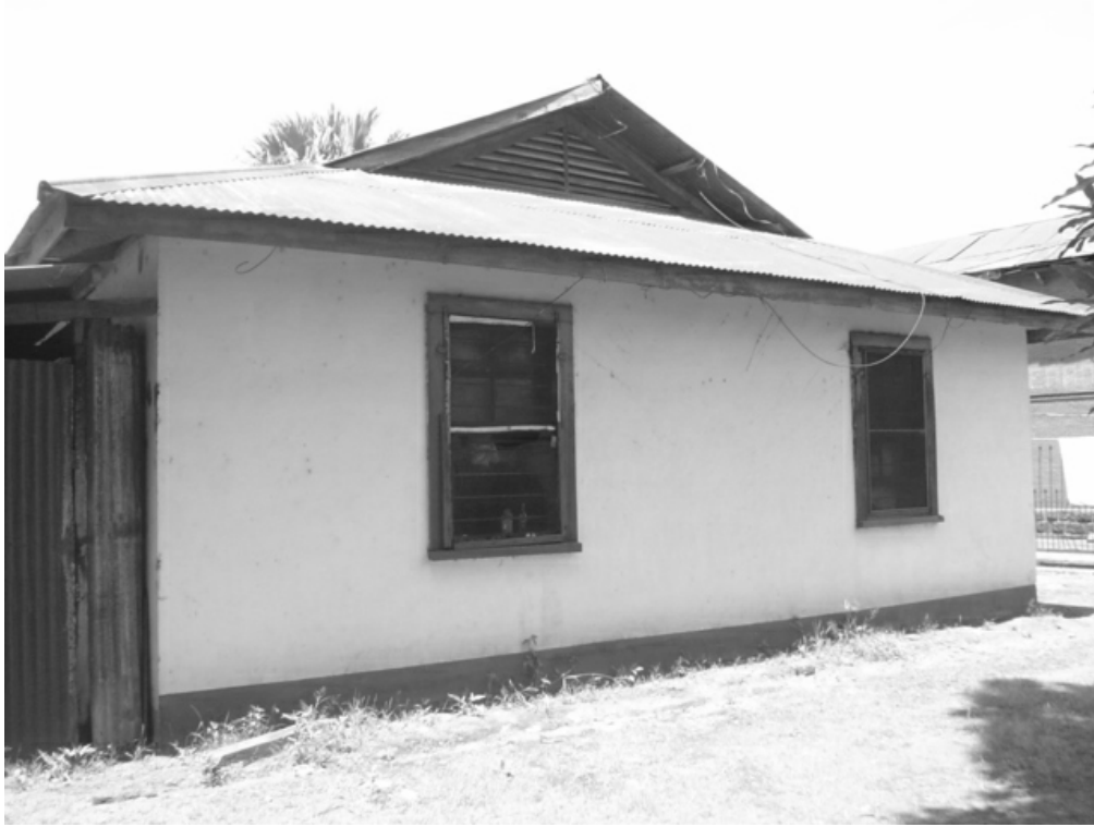
Foto 16: En esta fotografía se puede apreciar la conformación del techo, y la posición del cleristorio, el cual cumplía la función de darle ventilación e iluminación al salón que utilizaban como sala y comedor. Fuente Juan Mejicanos y Jorge Xiquin.
