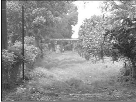
FOTO 38: EN LA FOTOGRAFÍA SE APRECIA ARCOS DE UN ACUEDUCTO QUE DATA DEL AÑO 1,900 ESTE CONDUCE AGUA A LA TERMOELÉCTRICA DEL INDE Y ES PASO IMPORTANTE PARA ALGUNOS HABITANTES DEL LUGAR.(FUENTE JUAN MEJICANOS Y JORGE XIQUÍN)
