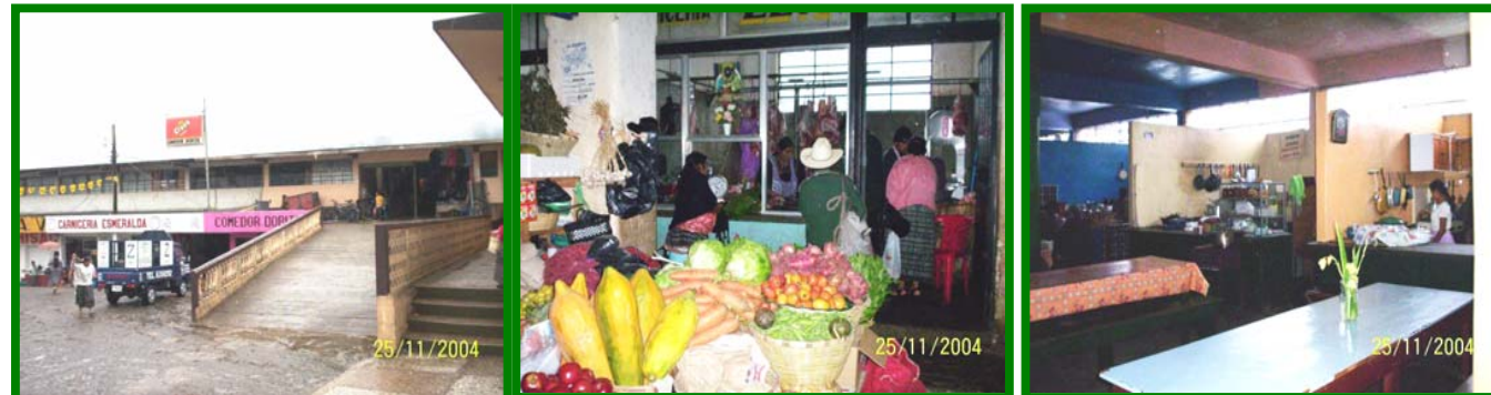
Edificio del Mercado Municipal de Tactic ubicado en el centro del municipio
