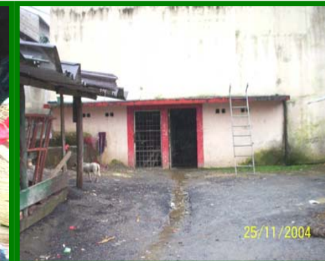
Área de ingreso a los servicios sanitarios y espacio utilizado para carga y descarga de productos al mercado.
