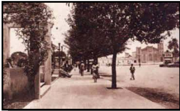
Calle del Parque Centenario zona 1 Guatemala. 46
