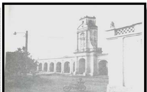
Antiguo Edificio municipal de Rabinal
