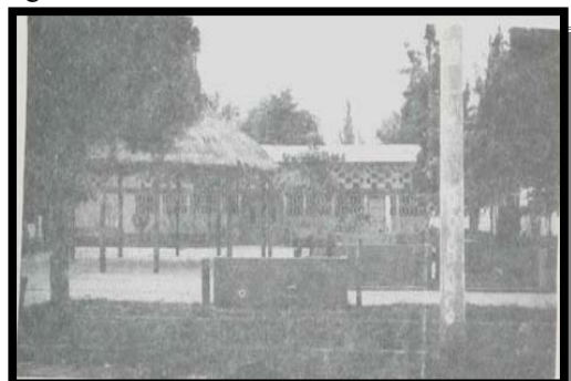
Antiguo Edificio municipal de CUBULCO
