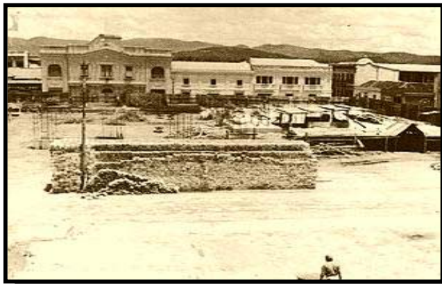
Construcción del Parque Central (Benito Juárez) Quetzaltenango. 49
