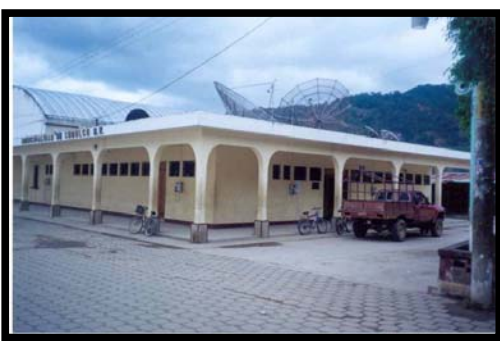
Nuevo Edificio municipal de CUBULCO
