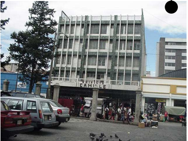
Foto # 39 El edificio Camilla utiliza para sus entrepisos y techo la losa reforzada, la ventanearía emplea vidrio y marcos de aluminio, como material de decoración en los muros exteriores aplicaron bloques cerámicos de imitación mármol.
