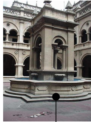
Detalle de la fuente que se encuentra en el centro de toda la construcción, en el patio del primer nivel.
