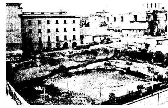
Foto # 68 Fotografía tomada desde un edificio ubicado en la esquina de la 14 calle y 7ª. avenida de la zona I, observándose un inmenso agujero producto de la ausencia de las estructuras del monumental ex – convento franciscano.
