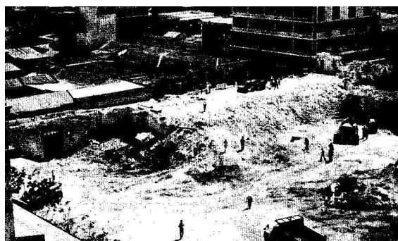
Foto # 67 Grado de avance de demolición del ex – convento, no importando las apelaciones hechas por el instituto de Antropología Etnología e Historia.
