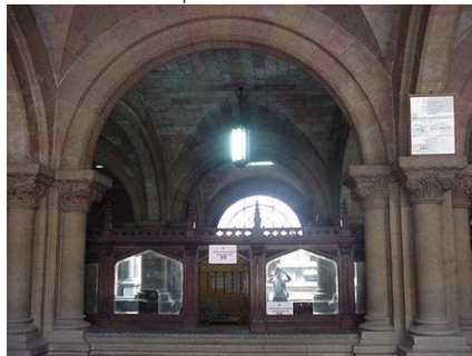
En el ala Sur se encuentra oficinas de atención de renuencias, se aprecia parte del mobiliario en madera tallada, la cual forma parte del inmueble.
