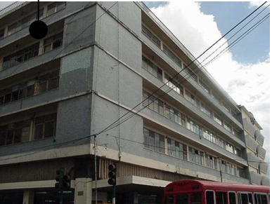
Foto # 38 Es evidente la utilización de concreto reforzado en la construcción del edificio Valenzuela ubicado en la 14 calle sobre la 6ª. Avenida de la zona I.
