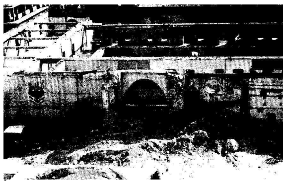
Foto # 66 En su fase de culminación de los trabajos de demolición, quedando solo los promontorios de rípio.
