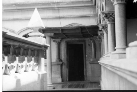
Corredor exterior en el ala este del tercer nivel, que circula el patio central.
