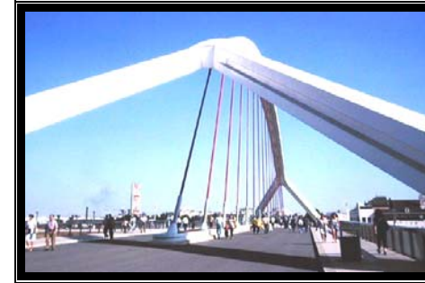
Puente de la Barqueta
