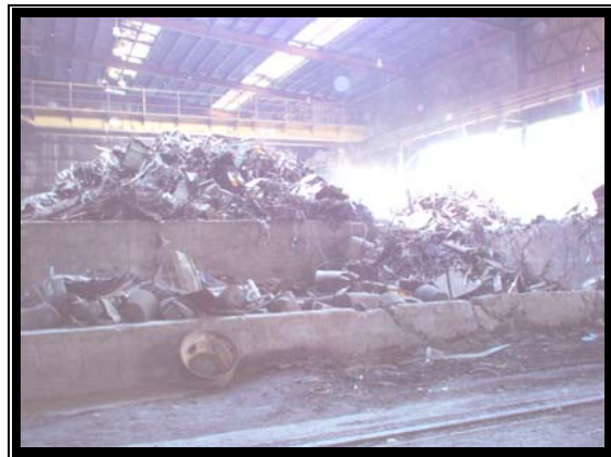
En la fotografía 1, Se observan los recintos de chatarra dentro de la nave de acería. Sobre ellos entre el techo y la chatarra la grúa de transporte horizontal hacia el horno.
