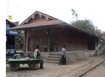
Foto No. 149 Estación El Rico. Estado actual, conservada y protegida por un grupo de pobladores.
