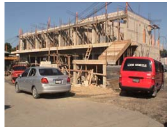
Fotografía No. 43 Ingreso Terminal de Buses. Construcción de Nuevos Locales Comerciales en área o patio de maniobras. Fuente: ALONZO, Carlos – LOPEZ, Ariech
