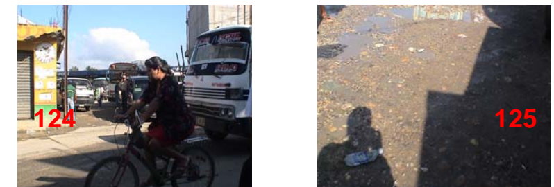
Fotografía No. 124 Salida Terminal de Buses y vía de circulación. Fotografía No. 125 Interior Terminal de Buses, estado del patio de maniobras y parqueo. Fuente: ALONZO, Carlos - LOPEZ, Ariech
