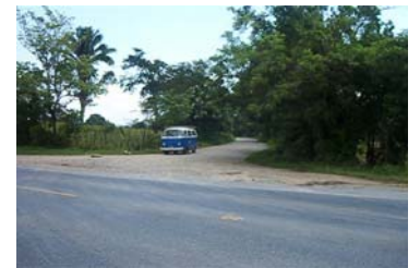
Fotografía No. 32 Acceso "D", Paso de San Francisco, Km. 240 Fuente: ALONZO, Carlos – LOPEZ, Ariech
