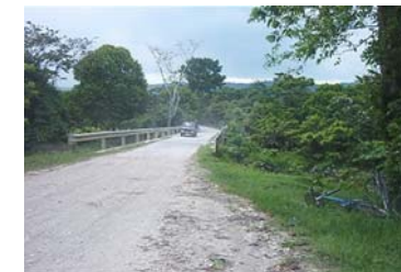
Fotografía No. 33 Puente San Francisco, acceso "D" Fuente: ALONZO, Carlos – LOPEZ, Ariech
