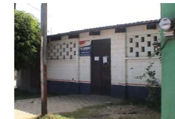
Fotografía No. 76 Oficina de Correos y Telégrafos. Fuente: ALONZO, Carlos – LOPEZ, Ariech
