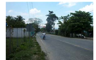
Fotografía No. 37 Tipo de Recubrimiento, asfalto, ingreso principal a Morales Fuente: ALONZO, Carlos – LOPEZ, Ariech
