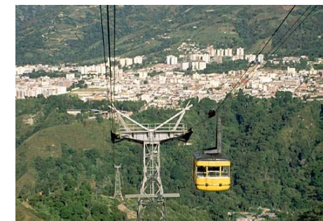
Fotografía No. 7 Teleférico de Mérida
