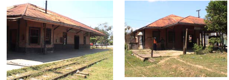
Foto No. 143 Estación Quiriguá milla 59.1 Foto No. 144 Alteración al edificio original. Agregado en patio, construcción de block para área de lavado y tendido.
