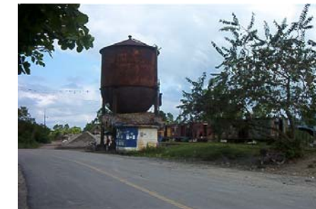
Foto No. 132 Depósito de Agua, infraestructura existente. Estación con parada técnica, según información recabada los depósitos aéreos de metal surtían de líquido (agua) a la locomotora del ferrocarril, para enfriamiento de su caldera.
