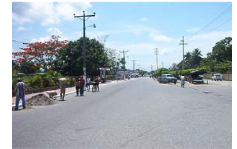
Fotografía No. 35 Tipo de Recubrimiento, pavimento de concreto, calzada principal Fuente: ALONZO, Carlos – LOPEZ, Ariech
