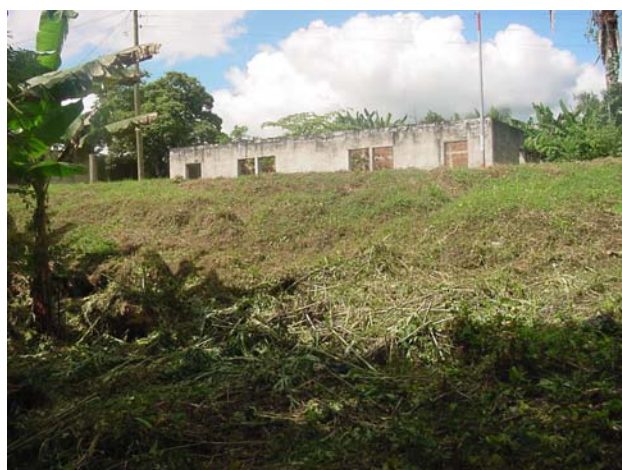
Foto No. 5 Mapa de análisis fotográfico: Vista del área quebrada del terreno. Al fondo la construcción abandonada del edificio de La Casa de La Cultura. (Fuente: Visita de Campo)
