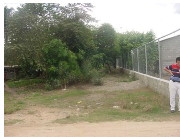
Foto No. 7 Mapa de análisis fotográfico: Vista parcial del muro perimetral del Instituto de educación diversificada, colindante con el predio, nótese que el desnivel del terreno es mínimo. (Fuente: Visita de Campo)
