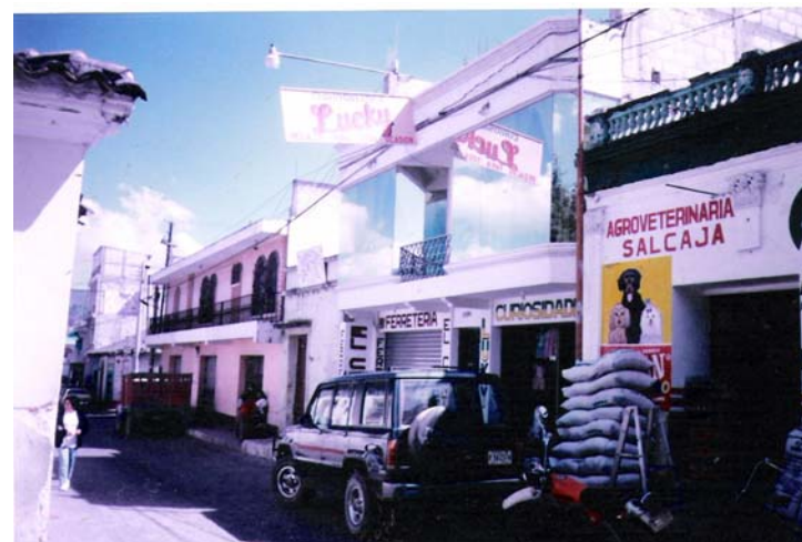
Foto # 14. Parte de la fachada norte con edificaciones originales demolidas y re-edificadas. Fuente: Propia
