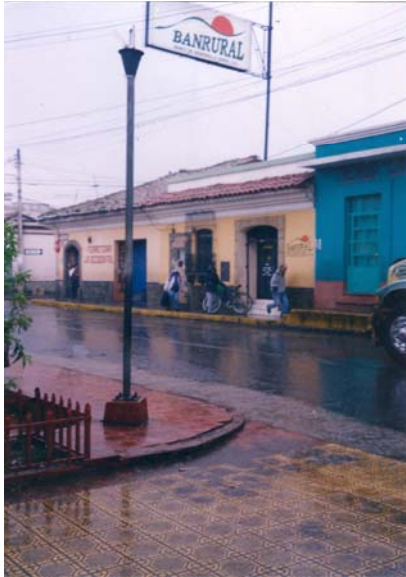
Foto # 16. Parte de la fachada norte con vivienda original con alteraciones físicas y conceptuales. Fuente: Propia
