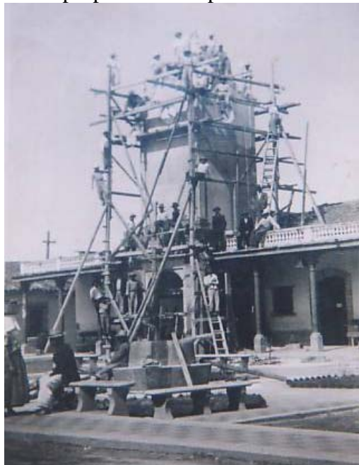
Durante la construcción de la Torre en 1953 Foto # 24. Fuente: (126)
