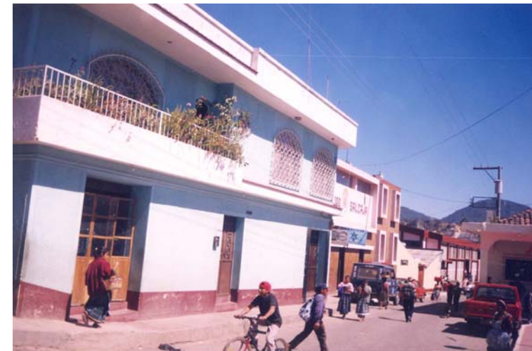
Foto # 19. Fachada sur con edificaciones originales demolidas y re-edificadas. Fuente: Propia
