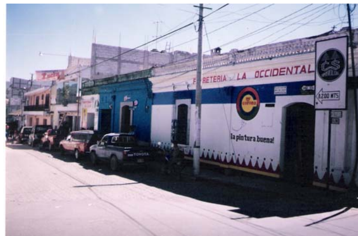
Foto # 15. Parte de la fachada norte con vivienda original con alteraciones físicas y conceptuales. Fuente: Propia
