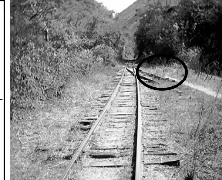
Foto No.20 Actualmente el desvío se encuentra dismantelado en un 90%. El entronque con la línea que se dirige a Puerto Barrios, es el único hallazgo que se registra en campo.
