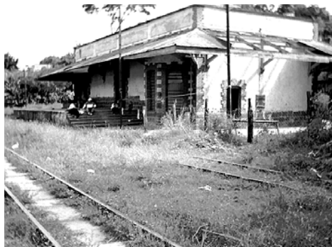
Foto No. 1: Estación Sanarate, tomada de Sur a Norte. (Observar daños mencionados anteriormente) Fuente: Investigación de Campo, febrero del 2004.
