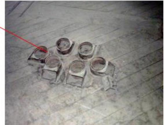
Fotografía No.179. Elementos metálicos que presentan perforaciones en el entrepiso del segundo nivel. 2004.
