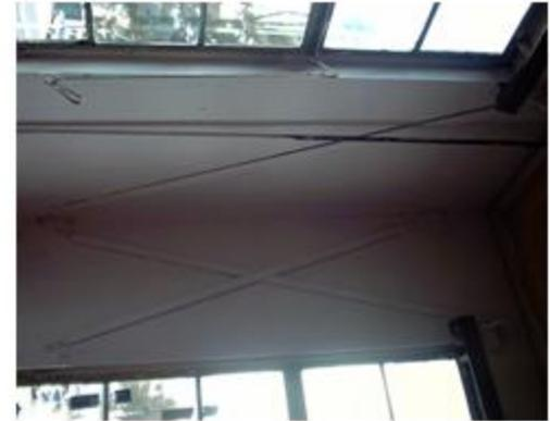
Fotografía No. 187. Interior del segundo nivel de la Estación, utilizada por los oficiales en la cual se observan refuerzos metálicos. 2004.
