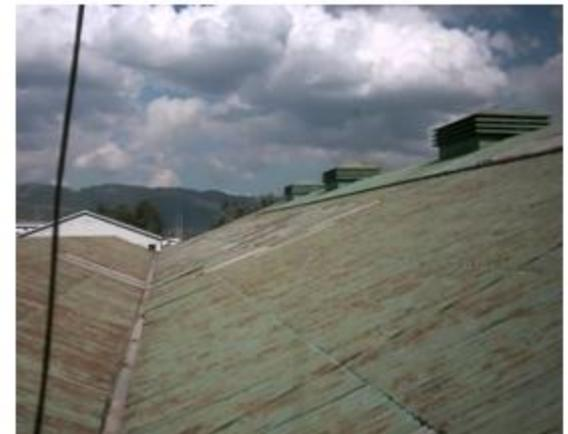
Fotografía No. 188. Techo en su estado actual en el cual se manifiesta el deterioro por oxidación en material No original.2004.
