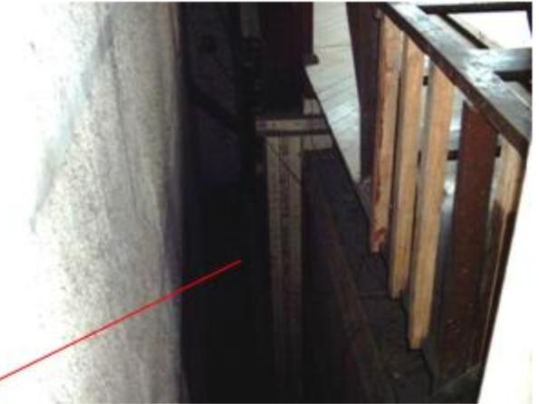
Fotografía No. 183. Detalle de la separación entre la estructura y el cobertizo.2004.
