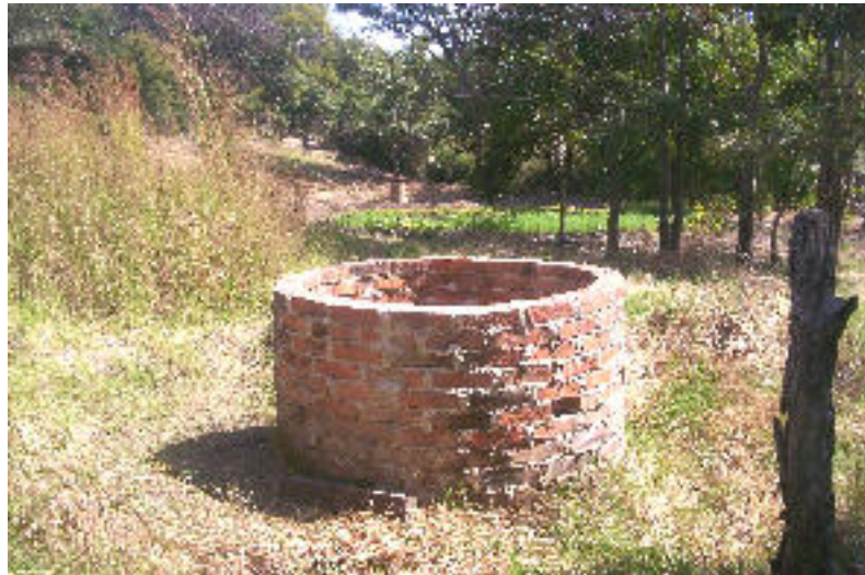
F9-VISTA HACIA POZO DE AGUA EXISTENTE
