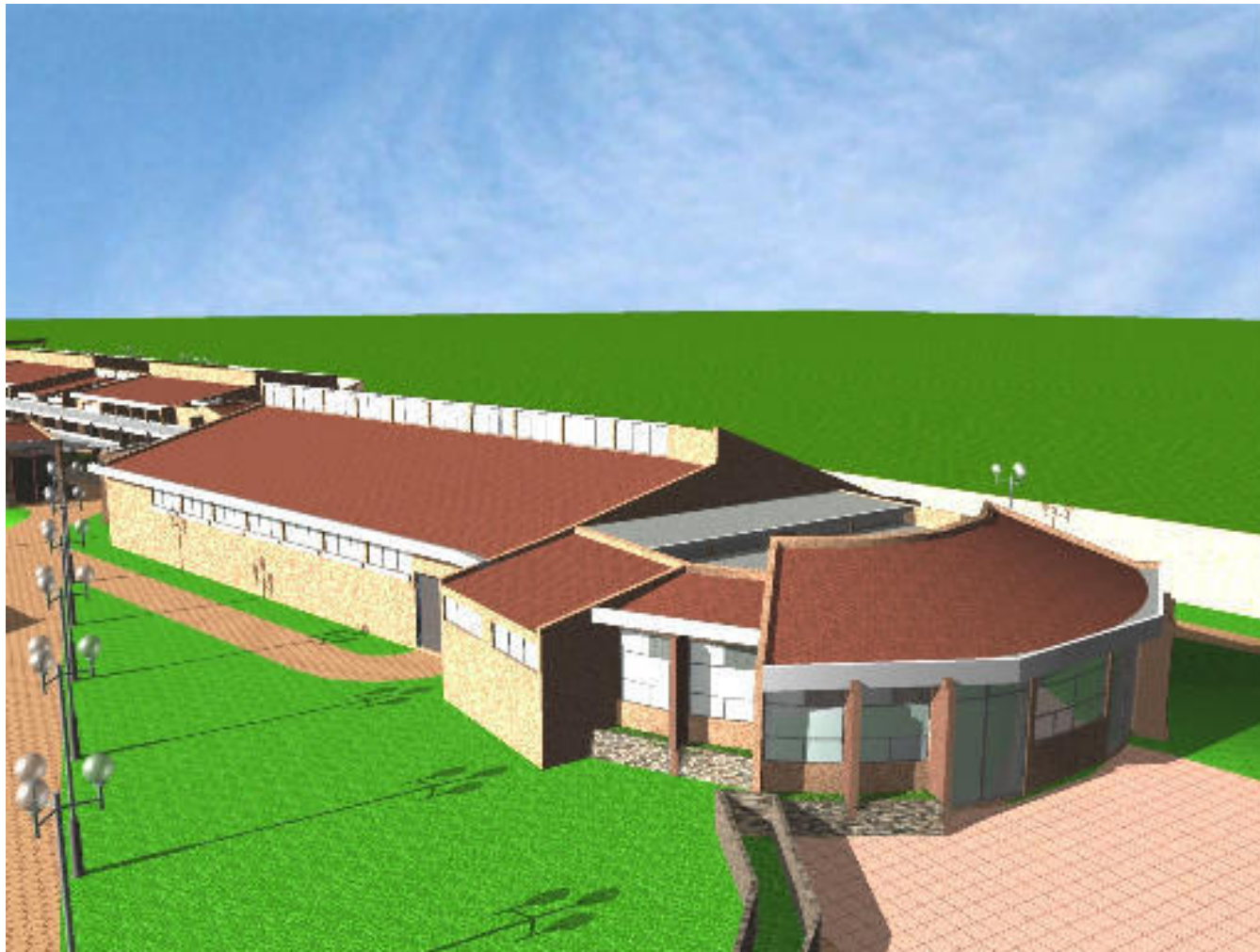
EDIFICIO DE S.U.M
