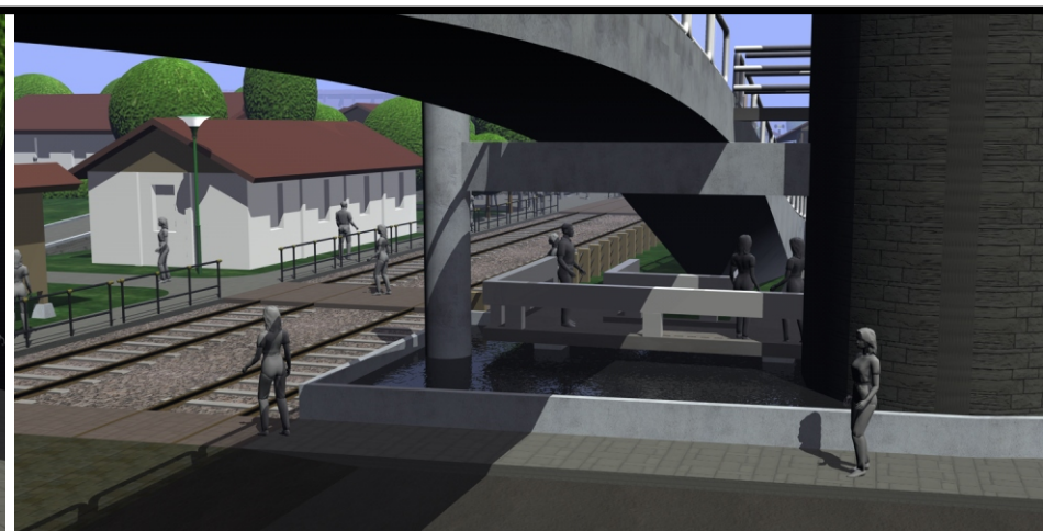
Imagen 10. Paso elevado sobre la 3a. Calle viendo hacia el sur donde se observa el tratamiento escultórico que se le ha dado al volumen de la pasarela. El cilindro de la derecha contiene las gradas para subir hacia la pasarela, para lo cual hay que pasar sobre una plataforma ubicada sobre un espejo de agua.
