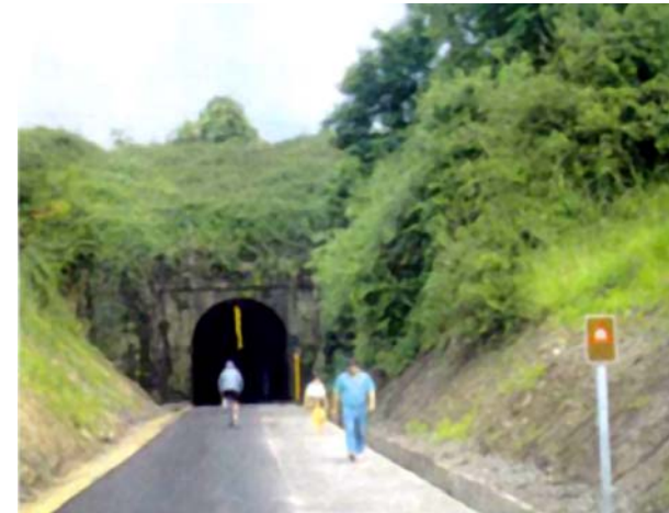
Foto No. 2-11. Diferentes tipos de superficie para los caminantes y para los ciclistas. Fuente: http://www.aevv-egwa.org .
