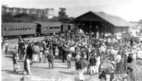
Foto 3-1. Edificio de la Estación del Ferrocarril de Chiquimula en su tiempo de operación año 1932. Fuente: Publi-Producciones de Oriente.
