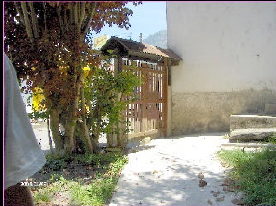
2. Se tomó una foto de un lado de la casa de la casa que se ve al interior de la casa de la casa parroquial, está cubierta por una estructura de madera que cubren a la casa de la casa exterior, los arcos están de una casa con una estructura de concreto, los arcos son muy sencillos al nivel de la fachada que están al interior de la casa parroquial, se ve como la estructura del arco.
