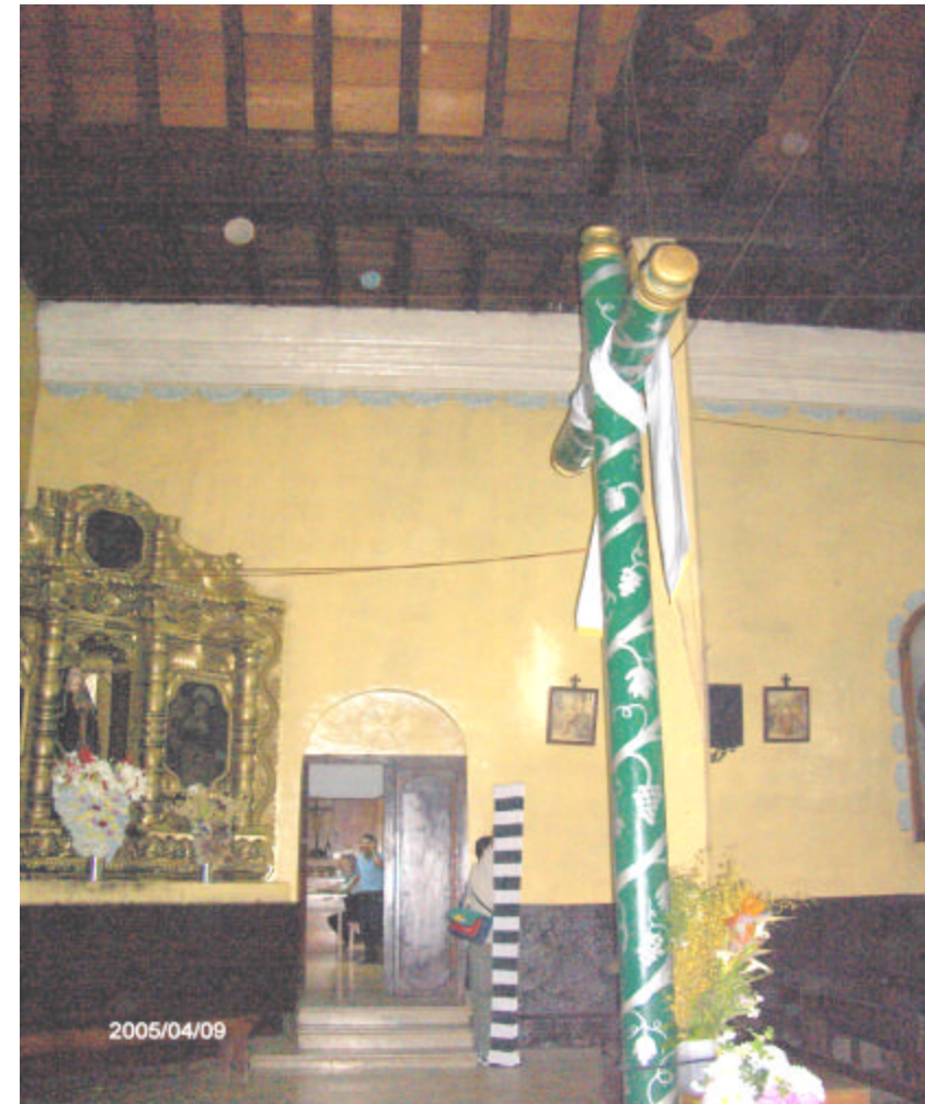
Fotografía de Ingreso a la Sacristía, tomada el 9 de abril de 2005. Fuente: Virginia Ramos Calderón, autora, Archivo propio .
