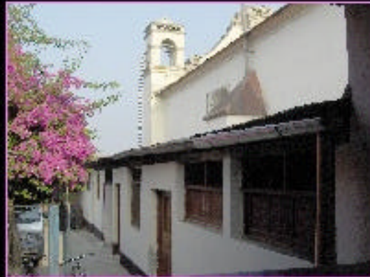
1. Fotografía de lado sur del Templo, se observan las subestructuras adosadas, así como la intervención de uno de los autorretratos por la ubicación del monasterio improvisado.
