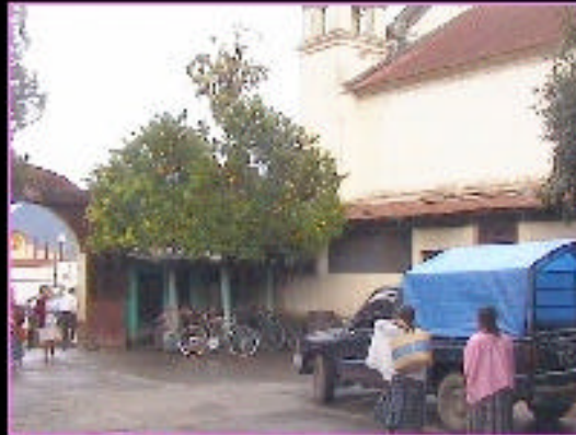
2. Fotografía de los muros que muestran problemas que se manifiestan en el pórtico de la casa parroquial y a su lado de la zona exterior del baptisterio, así como se observa la vegetación existente.
