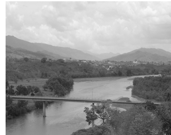
Puente de Ingreso a Casco Urbano de Gualán Foto: OMP, Gualán, Zacapa
