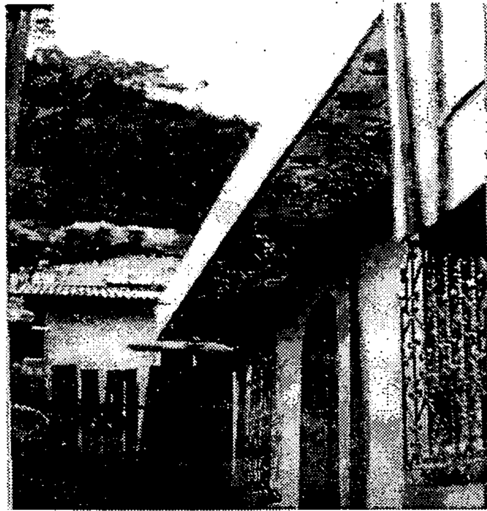
VIVIENDA UBICADA EN 5 AVENIDA ZONA 1.
