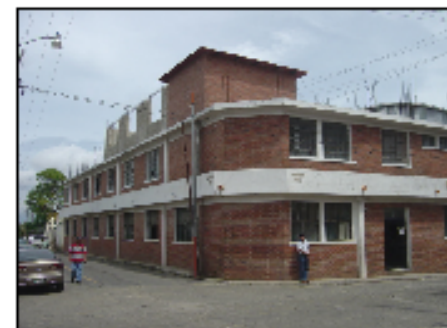
FOTO No. 4: EDIFICIO DE 3 NIVELES DEL INSTITUTO POR COOPERATIVA. UTILIZACIÓN DE FACHALETA DE LADRILLO EN MUROS Y BLANQUEADOS
