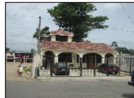
FOTO No. 6: EDIFICIO DEL JUZGADO DE PAZ. UTILIZACIÓN DE TECHOS INCLINADOS, ARCOS
