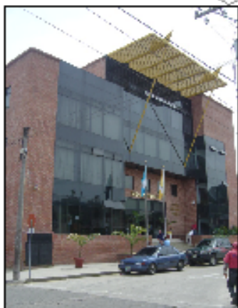
FOTO No. 1: EDIFICIO ACTUAL MUNICIPAL DE 4 NIVELES + 1 SOTANO. UTILIZACIÓN DE LADRILLO DE BARRO COCIDO Y VIDRIO.
