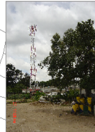
Foto #2: Torre de teléfono de Telgua la cual se ubica dentro de terreno en Colonia Santa Barbara. Esta torre de servicio a toda zona de influencia.
