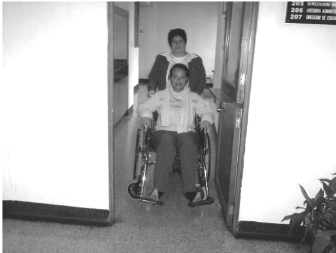
Fotografía No. 51. Tanto en el edificio del Comité, como en todo el edificio de uso público es recomendable que la puerta de salida o entrada al edificio tenga un ancho mínimo de 1.00 metro para brindar comodidad a sus trabajadores y usuarios con discapacidad. Fuente: propia 2005.
