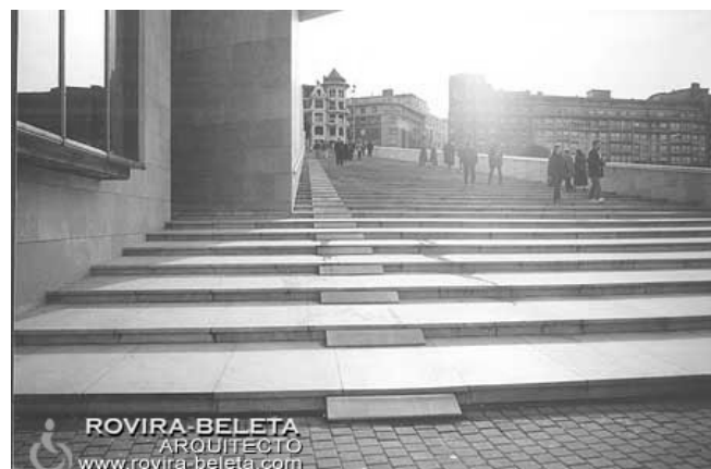
Fotografía No. 10. Otra forma sencilla de convertir parte del módulo de gradas en rampa es diseñando cuñas, que se adapten a la forma. Fuente: www.rovira-beleta.com , 2005.
