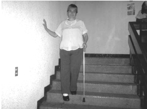
Fotografía No. 53. (Diseño: Elaboración propia ). Deberá colocarse pasamanos en el área de gradas para que las personas con discapacidad puedan apoyarse. Fuente: propia, 2005.
