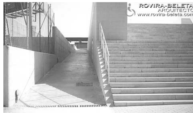
Fotografía No. 09. La forma más común de crear rampas es la adosada a las gradas. Totalmente independiente. Fuente: www.rovira-beleta.com , 2005.
