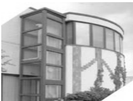
Fotografía No. 07. Módulo de ascensor, especialmente diseñado para personas con discapacidad física. Fuente: grupodorados@yahoo.es , 2005.
