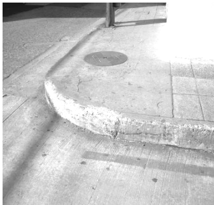
Fotografía No. 45. En todas las calles existen esquinas redondeadas pero no existe diseño en ellas que contribuya con personas discapacitadas. Fuente: propia, 2005.
