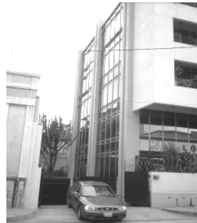
Fotografía No. 43. No existen escaleras y salidas emergencia. Fuente: propia, 2005.
