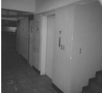
Fotografía No. 14. Ascensor con servicios sanitarios y parqueo del sótano. Fuente: Propia, 2005.
