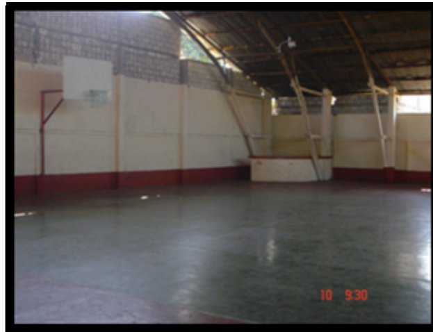
Fotografía salón municipal Fuente: propia.
