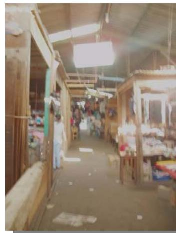
En detalle un pasillo central del área de piso plaza, así mismo se puede observar el tipo de estructura metálica con vigas tipo I y el techo de lamina que cubre el área de piso plaza.
