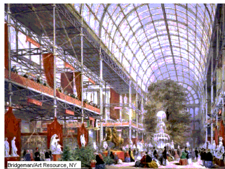
Ilustración 11.6. Interior del Crystal Palace. Joseph Paxton proyectó el Crystal Palace para albergar la Exposición Universal de 1851, celebrada en Londres. Su construcción, consistente en una estructura ligera de hierro colado y un cerramiento de cristal, fue pionera en el campo de la prefabricación, y marcó un hito decisivo en la evolución de la arquitectura moderna.
