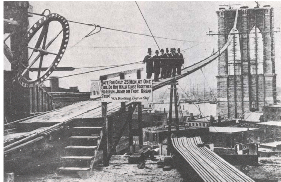
Ilustración II.2. J.A. y W. A. Roebling, el puente de Brooklyn, Nueva York, en construcción c. 1877.
