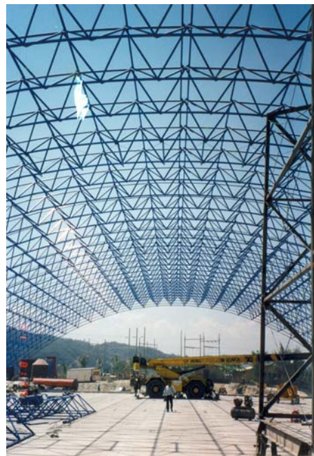
Ilustración V.42 – V.44 Estructura Curva de 70.00 m de luz de Cementos Progreso, S. A.
