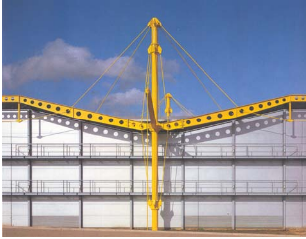
Ilustración II.31 & II.32 Distribuidora Renault en Swindon / Wiltshire, 1981-1983. Foster Associates (arq.), Ove Arup and Partners (ing.) Foto Richard Davies
