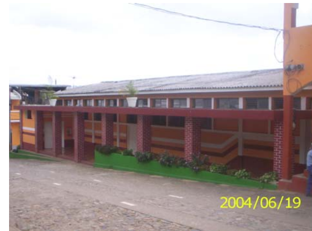
Fotografía No.18 Vista exterior del Salón Municipal.
