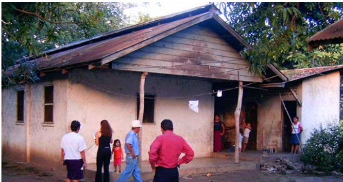
Foto No. 30. Vivienda 6 del Conjunto Ferroviario de Gualán.
