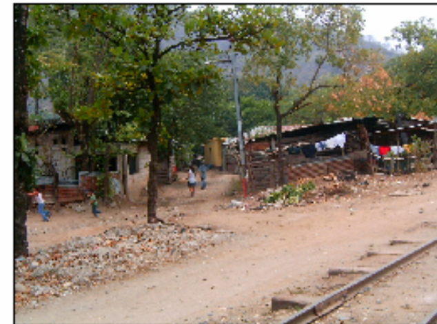
Foto No. 18. Aquí se observan las invasiones colindantes al terreno del conjunto de la Estación de Gualán.
