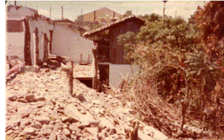
Foto No. 12. Escombros de las viviendas de adobe. 72
