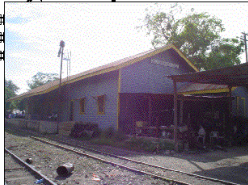
Foto No. 47. Elevación lateral izquierda.
