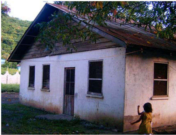
Foto No. 29. Vivienda 5 del Conjunto Ferroviario de Gualán.
