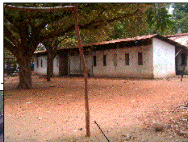
Foto No. 58. Vista frontal de las viviendas 1 y 2
