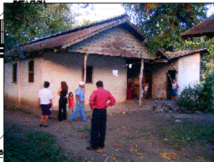
Foto No. 5D. Vista lateral de la vivienda No. 6, totalmente de concreto armado.
