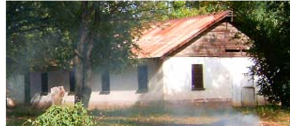
Foto No. 27. Vivienda 3 del Conjunto Ferroviario de Gualán.
