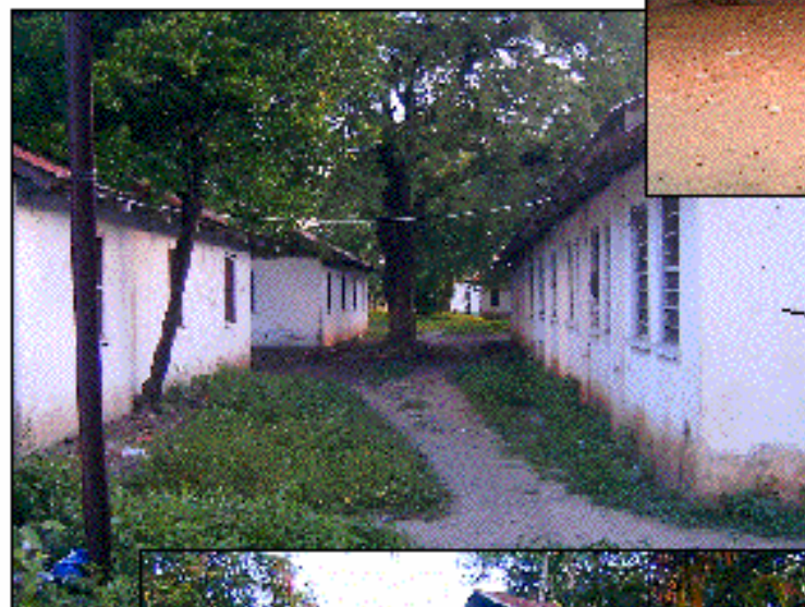
Foto No. 57. Vista lateral de viviendas, en ningún momento se ven las viviendas
