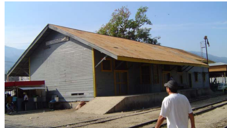
Foto No. 24. Estación de Gualán.
