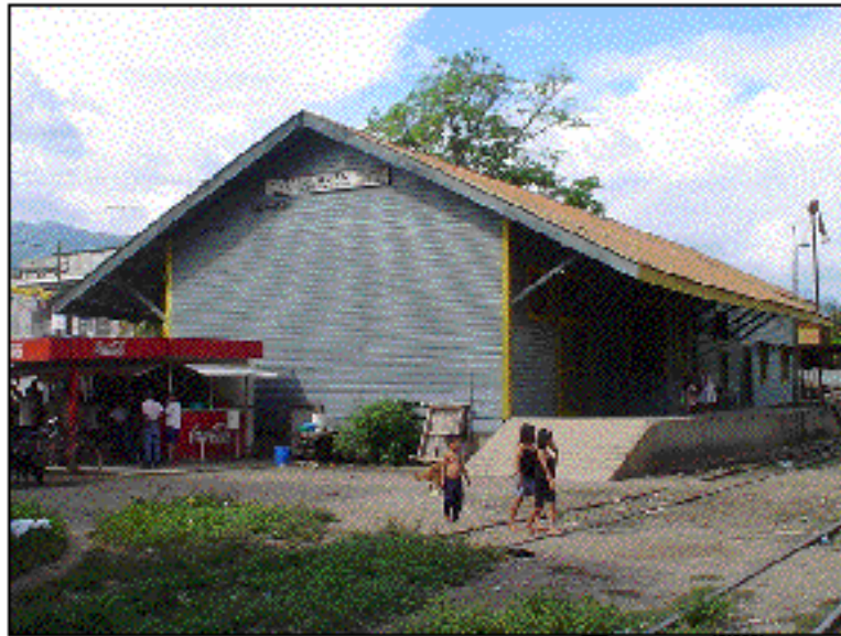
Foto No. 44. Elevación lateral Derecha. En donde se pueden observar los vertidos que continúan a parte del terreno de la Estación.
