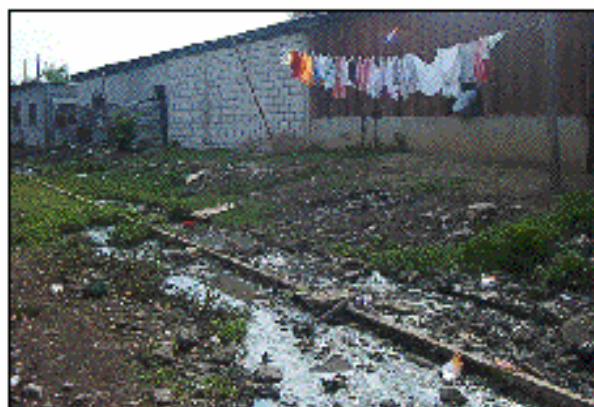
Foto No. 79. Business ilegal ubicado frente a la bodega de mantenimiento, lo cual afecta también el desplazamiento del ferrocarril, pues se encuentra sobre la línea férrea. Además se puede observar la continuación de vías y el riesgo que corren los pasajeros en esta área.
