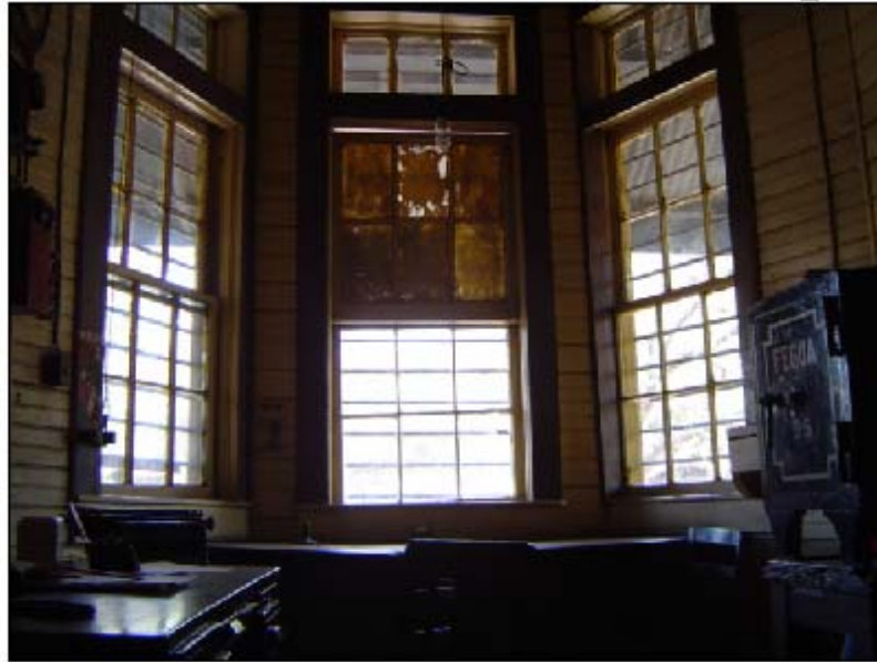
Foto No. 42. El área que se observa en esta fotografía es la venta de boletos. Se pueden apreciar los ángulos a 45° de este ventanal, lo cual es característico de las edificaciones ferroviarias debido al estilo victoriano.
