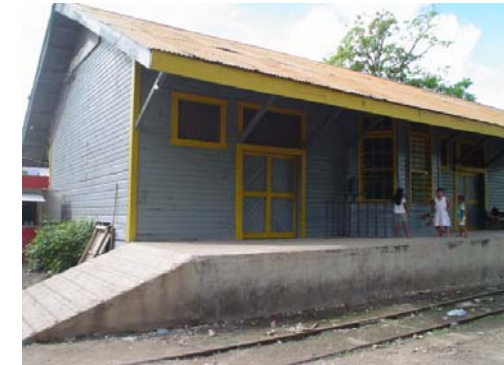
Foto No. 84 Vista Estación de Gualán.
