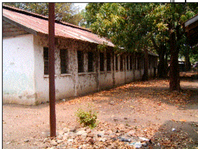
Foto No. 54. La fotografía nos muestra la parte posterior de las viviendas, en la cual podemos observar como los cambios climáticos han afectado seriamente el repello de los muros así como los techos de las viviendas se están cayendo.
