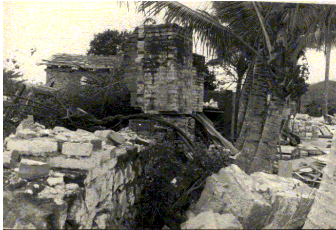
Fotografía No. 11. Colegio de Gualán después del terremoto. 71
