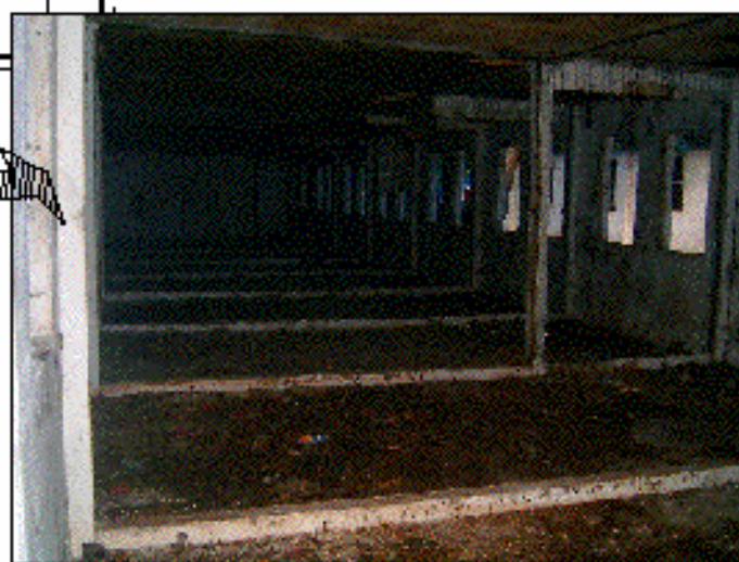
Foto No. 54. La fotografía nos muestra la parte posterior de las viviendas, en la cual podemos observar como los cambios climáticos han afectado seriamente el repello de los muros así como los techos de las viviendas se están cayendo.
