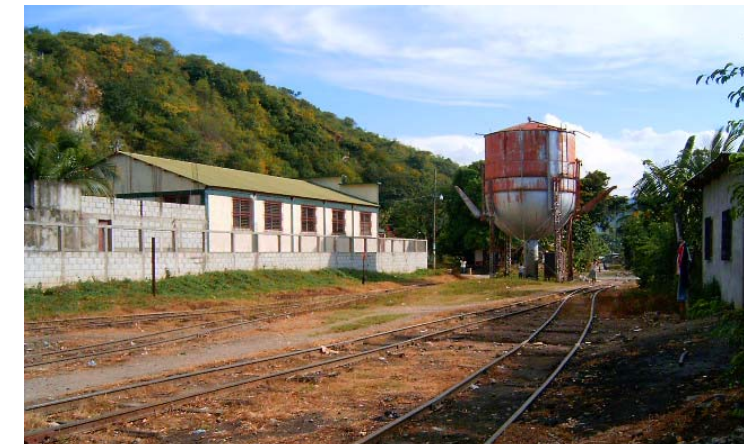
Foto No. 94 Daños de la Línea Férrea.
