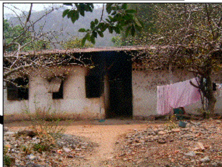
Foto No. 53. En esta fotografía podemos observar como los techos de las viviendas no les brindan el mantenimiento adecuado ya que las paredes se encuentran manchadas por el humo de los ambientes que utilizan como cocinas.
