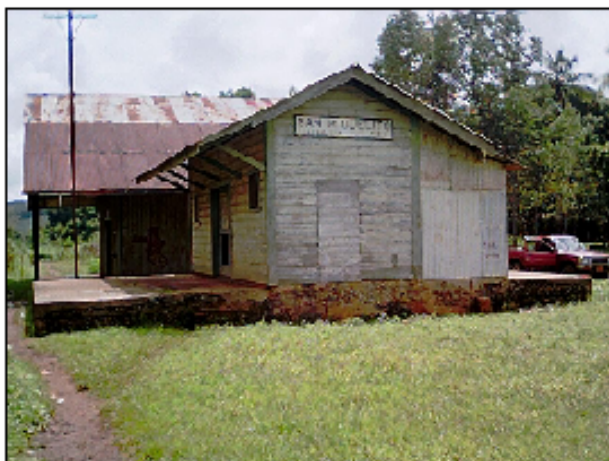
Foto No. 5. Vista Lateral de la Estación San Miguelito
