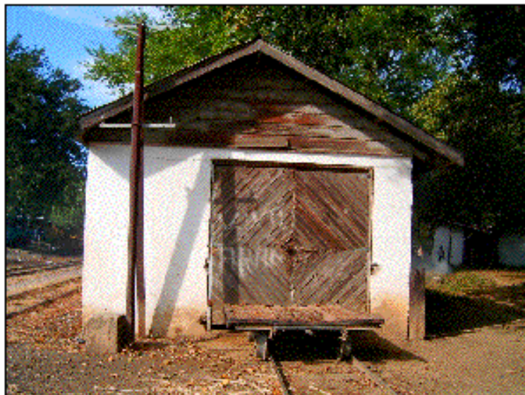
Foto No. 48. La fotografía muestra el frente del área de mantenimiento, en la cual podemos observar el deterioro de la maderera debido al abandono así como la presencia de vandalo.
