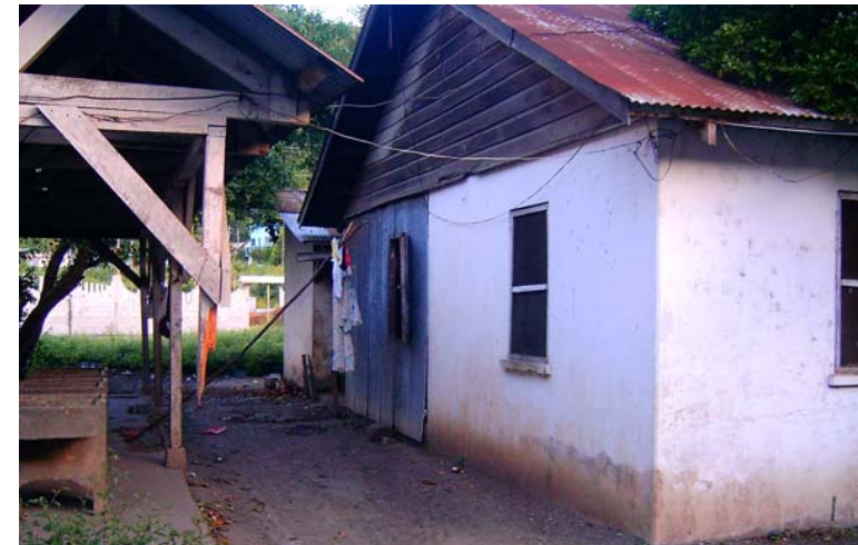
Foto No. 28. Vivienda 4 del Conjunto Ferroviario de Gualán.
