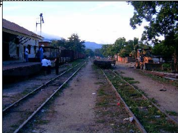
Foto No. 43. Aquí se puede apreciar la línea férrea que se dirige hacia Puerto Barrios.
