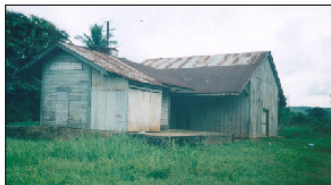
Foto No. 6. Vista Posterior de la Estación San Miguelito
