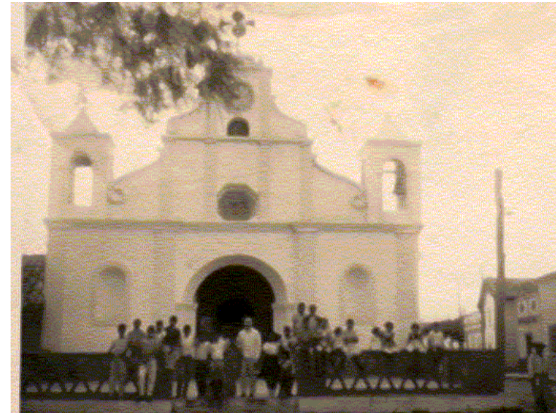
Foto No. 9. Iglesia parroquial antes del terremoto de 1976.
