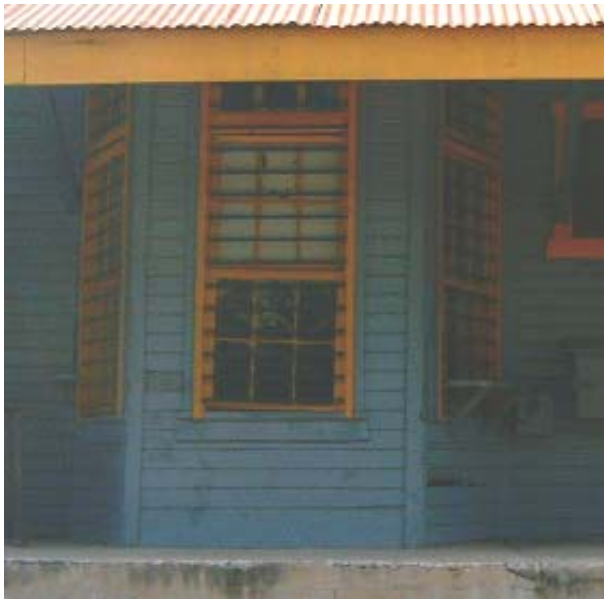
Foto No. 32. Ventanas de la Venta de Boletos.
