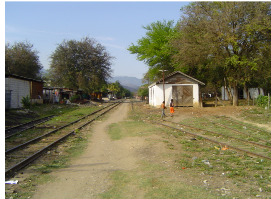
Foto No.99 derecho de vía de la estación de Gualán
