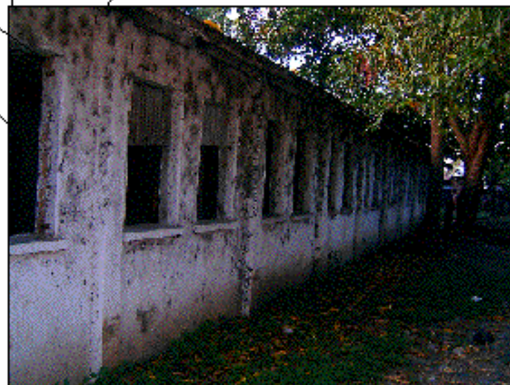
Foto No. 59. Vista posterior de las viviendas 1 y 2, se puede observar como los techos de palma han afectado los muros.
