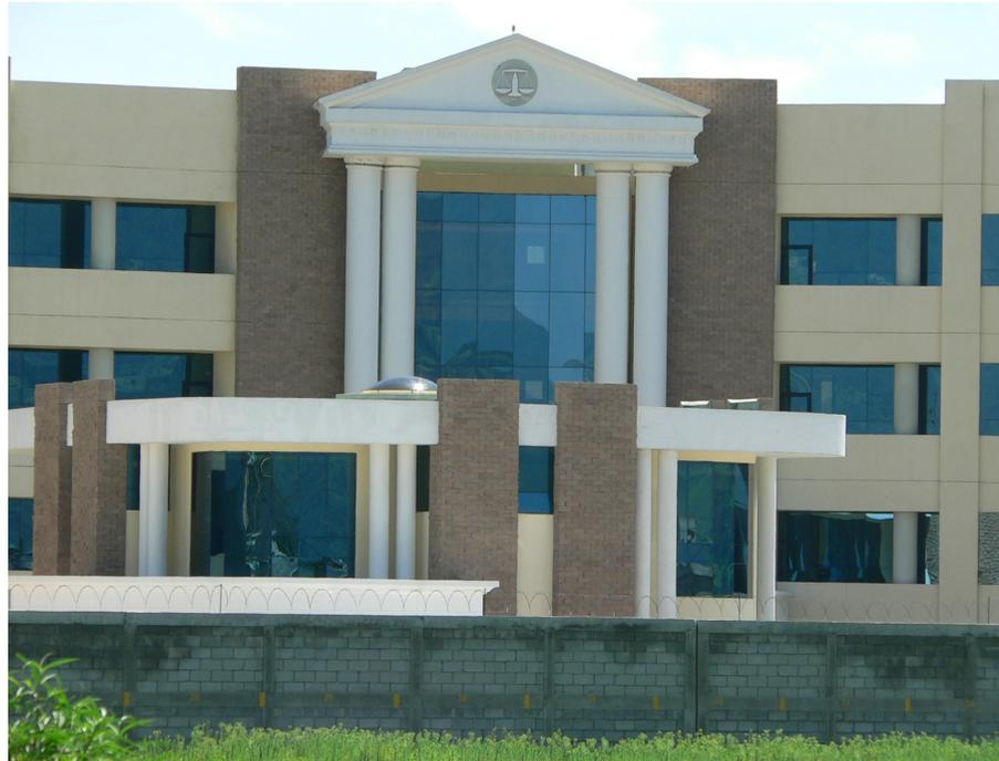
El muro exterior es de block visto cizado con alambre espigado para dar protección y seguridad a la infraestructura. Las columnas circulares y los salientes de rustiblock se repiten para darle simetría y armonía.
