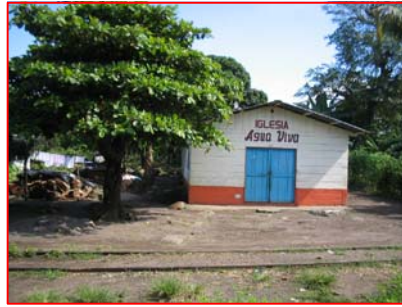
foto 38 dentro de la invasión se ubica una iglesia evangélica, siendo esta la única que cuenta con una construcción formal de muros sillar de block, tabiques de madera y cubierta de lámina.
