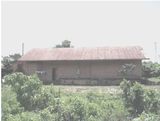
foto 6-22 Elevación norte de la estación
