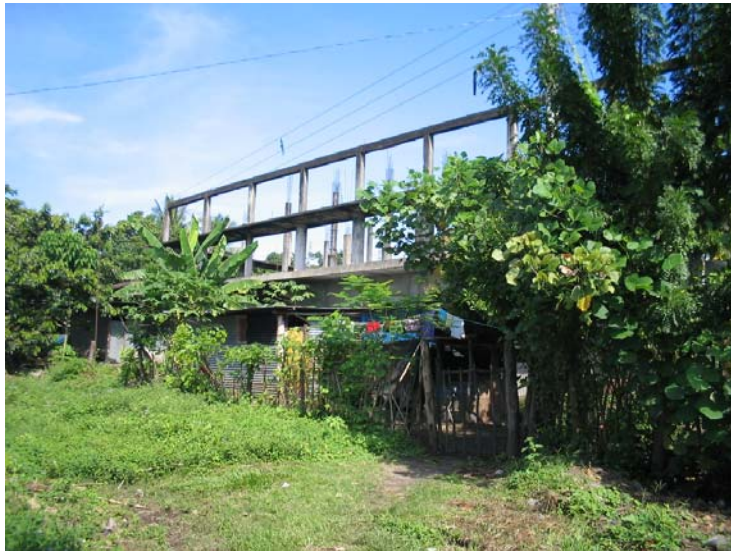
foto 6-59 se observa parte del complejo turístico en proceso de construcción que se encuentra en estado de abandono, el mismo cuenta con acceso desde la carretera del pacífico y como se nota en la fotografía acceso desde la estación.
