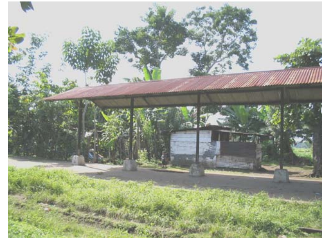
foto 6-51 anden de abordaje de la estación Muluá
