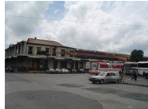
Foto 2-14, Estado actual del Edificio Estación Central de Ferrocarriles de Guatemala, 2003. Fuente: Jorge Maldonado.
