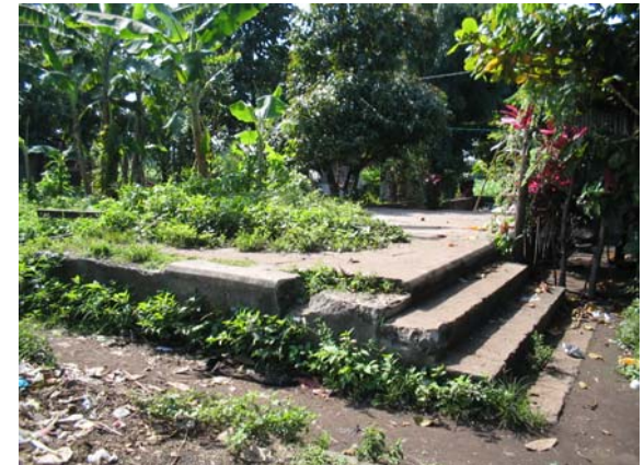
foto 1- 04; sólo queda la plataforma donde se ubicaba la estación de Santa Cruz Muluá, la misma fue demolida.
