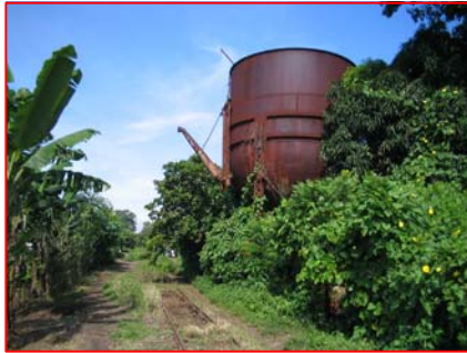
foto 32 terrenos de la finca los Brillantes, el tanque de acero de 30,000 galones, al centro la vía.
