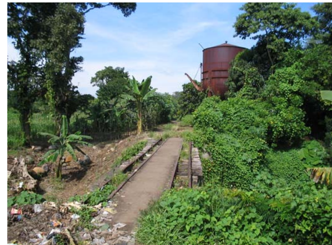
foto 6-55 el puente sobre el río Muluá marca el inicio del polígono de la estación, a la par de la vía se ubica el depósito de agua de 30,000 galones.
