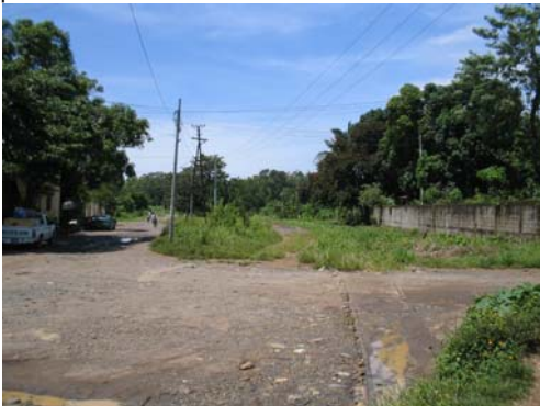
Foto 6-07 tomada del lado oriente con vista hacia la estación, se observan restos de la línea férrea, la calle que divide la estación con la colonia la Paz y el acceso de la colonia Brisas del Xulá con 75 viviendas
