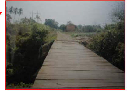
foto No.2 El puente sobre el Río Ican conserva su estructura original, al mismo se le han quitado los rieles y durmientes, siendo sustituidos por tabloncillos de madera para habilitar el paso vehicular, este tramo es utilizado ocasionalmente por vehículos livianos y pesados.
