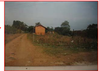
FOTO No. 1 Puede observarse la estación de Cuyotenango, en un tramo de aproximadamente 500 metros en el derecho de vía se esta utilizando como camino alternativo al unir la ruta del atlántico en ambos extremos de la población, durante el camino los rieles y durmientes de madera de la línea férrea se han quitado para colocarle balastro y habilitar el paso de vehículos, anteriormente se había planificado por las autoridades municipales la habilitación de un tramo carretero.
