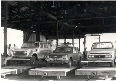
Foto 2-02 Carga de vehículos en el Puerto San José. Fuente: archivo FEGUA.
