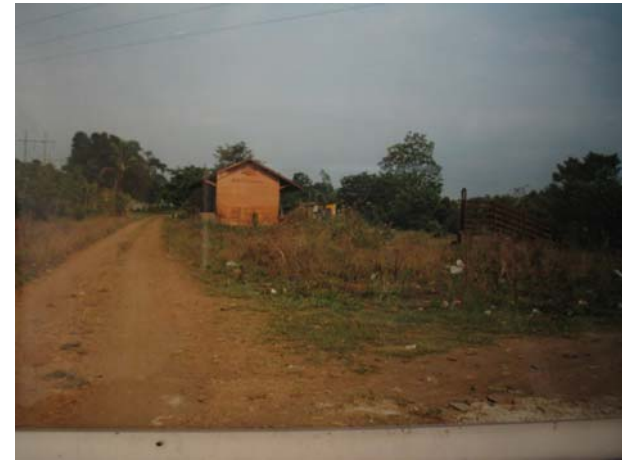
foto 6-16 vista de la estación, se observa el terreno baldío hacia la finca xulá en el lado norte.
