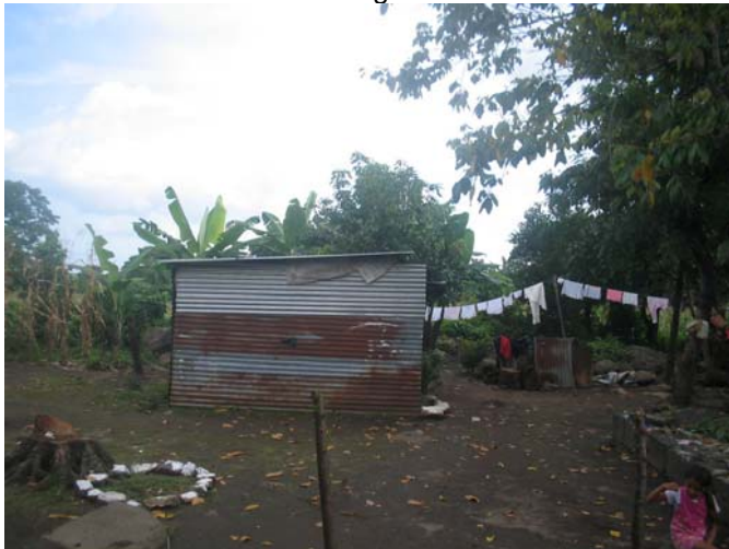
foto 6-69 viviendas de construcción informal deterioran la visual del conjunto.
