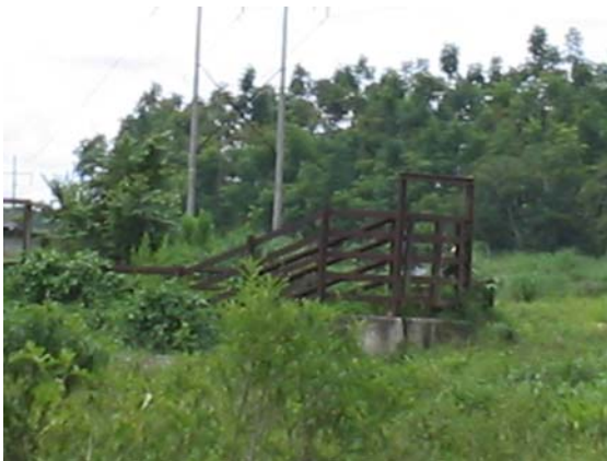
foto 15 la rampa y la estructura de rieles de vía utilizada para el embarque de ganado de la región en vagones del ferrocarril.
