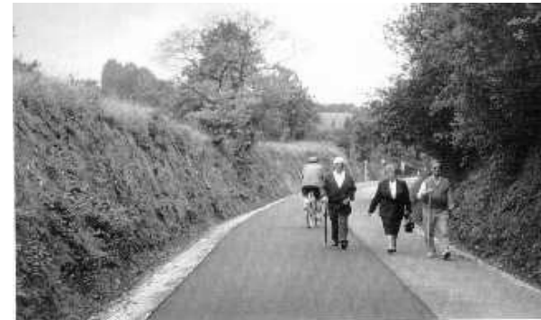
La solución de emplear diferente tipo de superficie para los caminantes y para los ciclistas facilita el multiuso, evitando conflictos entre los distintos usuarios (Vía Verde de La Camocho)
