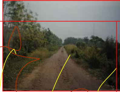
foto No.3 Por una longitud de 500 metros se a partir de la estación hasta el cruce con la carretera asfaltada que conduce al Municipio de San Jose Villa Seca se ha sustituido por un camino de terracería en donde se encontraba la línea férrea, se puede observar la ausencia de invasiones.
