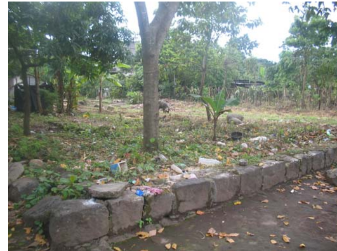
foto 6-52 cimentación de la plataforma del edificio de la Estación.
