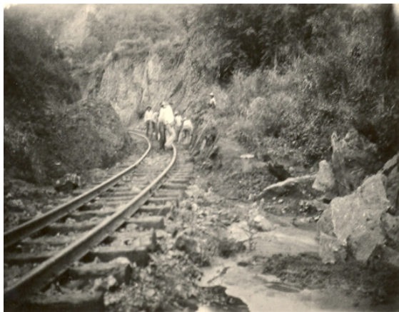
Foto 2-,11 Cuadrilla de mantenimiento de vía. Fuente: archivo FEGUA.
