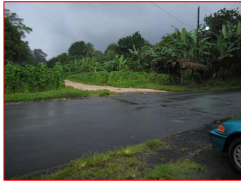
Foto No. 4 El cruce de la línea con la carretera que conduce al municipio de San José Villa Seca, se observa que después de la carretera ya no continúa el camino de terracería, la carretera conecta con la carretera del pacífico.
