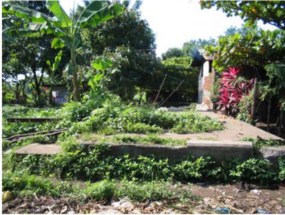
foto 6-50 se puede observar la plataforma de concreto del edificio adicional de la estación, el mismo fue desmantelado totalmente
