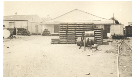
Foto 2-06 Bodegas de carga del Puerto San José. Fuente: archivo FEGUA.
