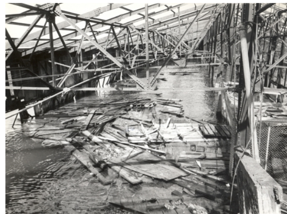
Foto 2-12. Daños a la estructura en el interior del Muelle Puerto Barrios por sismo de 1976. Fuente: archivo FEGUA.
