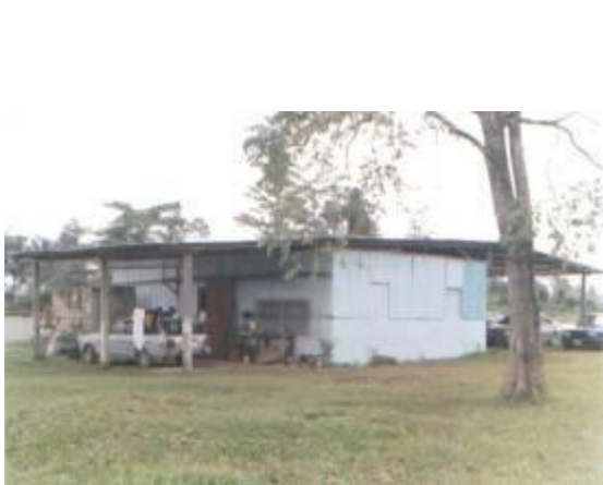
Lado sur se aprecia un pequeño garaje improvisado. Esta es el área de taller para las unidades de la estación
