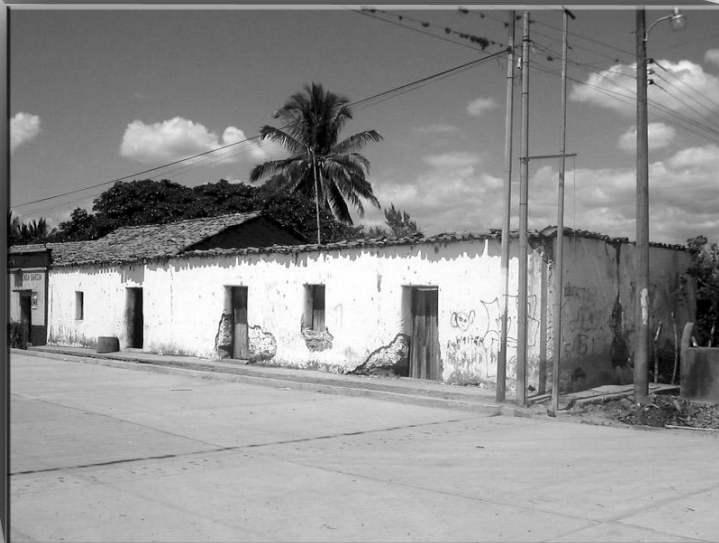
EDIFICACION ED-08 Vivienda Unifamiliar Edificación de uso residencial. Su construcción es antigua de adobe y cubierta de teja. Poco mantenimiento.
