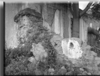
Fotografías No. 44, 45 y 46. Presentan el estado actual de los muros, nótese la reunión de los materiales para la construcción de éstos: la piedra labrada para esquinas como es el caso de la primera fotografía, el adobe, el ladrillo y la argamasa de cal para juntarlos, así también se ve la erosión en los muros, como el desprendimiento del acabado.
