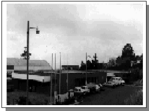
FOTOGRAFÍA No.2 INSTALACIONES FUNDABIEM Z.8 DE MIXCO, GUATEMALA 5
