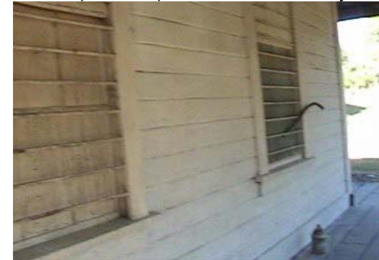
Fotografía 91 vista frontal del corredor edificio 1.
