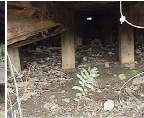
Fotografía 82 vista de la cimentación del edificio 1.
