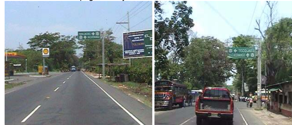
Fotografía 44, de la carretera CA-2, la cual conecta con la aldea cocales y varios puntos de la República de Guatemala.
