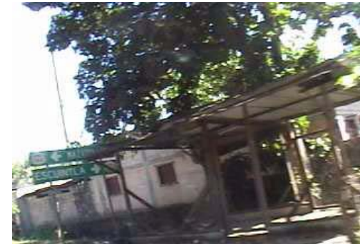
Fotografía 62 vista frontales del entorno de la estación Patulul.
