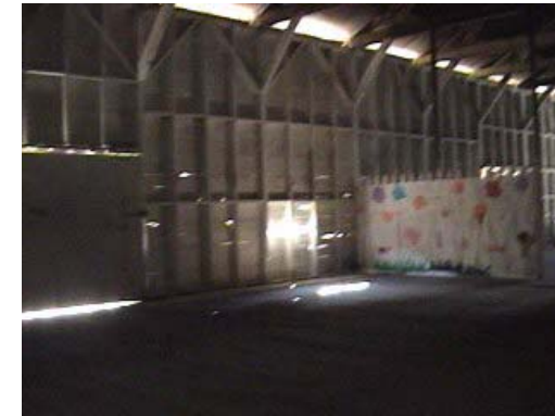
Fotografía 93 interiores del muro tabique edificio 1.
