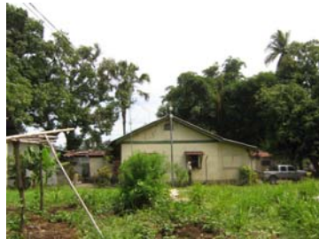
Fotografía 140 , Edificio Administrativo de la Hacienda Cocales
