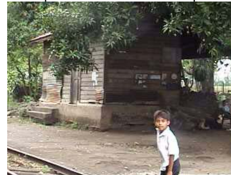
Fotografía 177, Estación Variedades parte frontal y Lateral derecha.
