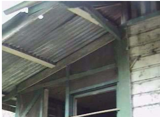
Fotografía 120 se aprecia la vista lateral derecha y el ingreso lateral derecha de la vivienda del telegrafista Estación Patulul (edificio 3).
