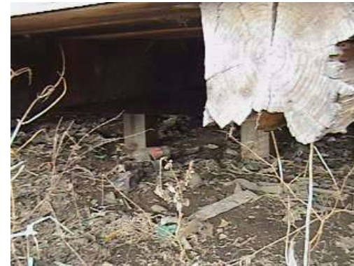
Fotografía 83 vista de la viga del edificio 1.
