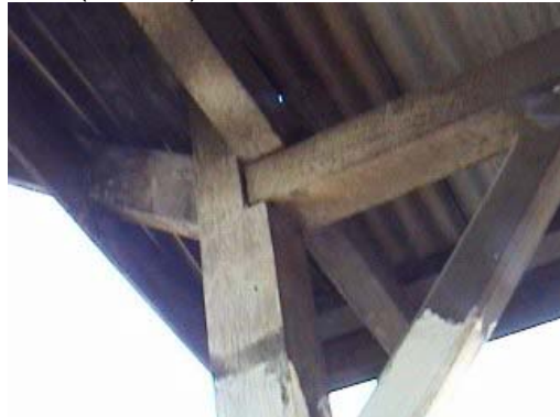
Fotografía 99 uniones de estructura del techo en el edificio 1.
