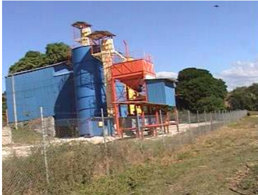
Fotografía 77 se aprecia la fábrica de vidrio que se encuentra dentro del complejo Arquitectónico de la estación de Patulul.
