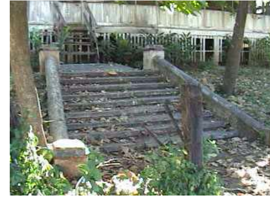
Fotografía 114 se aprecian las escalinatas de acceso a la vivienda del telegrafista (edificio 3).
