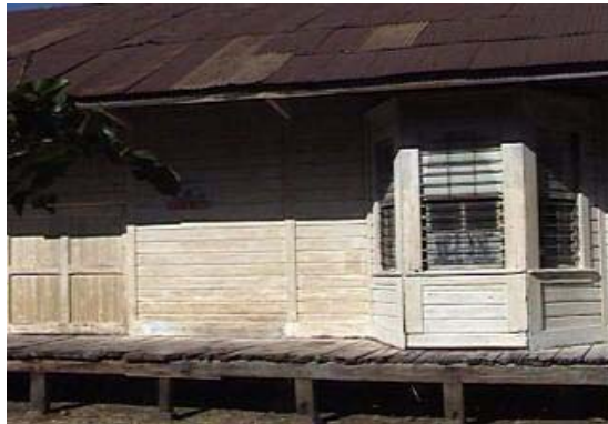
Fotografía 95 vista lateral izquierda edificio 1 (taquilla).
