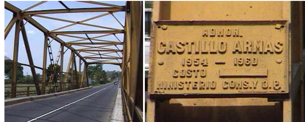
Fotografía 42-43 del puente del río Madre Vieja ubicado a pocos metros del casco urbano de Patulul, abril 2004.
