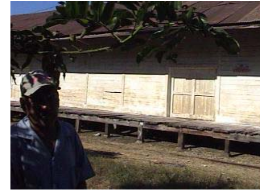
Fotografía 90 vista lateral izquierda edificio 1
