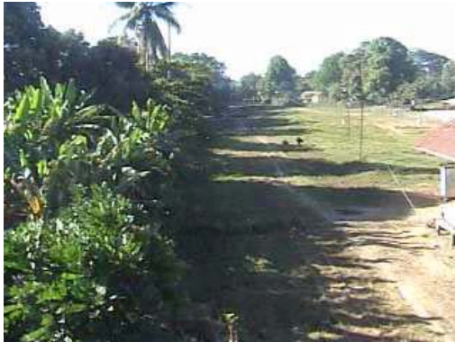
Fotografía 74, vista panorámica del Conjunto de la Estación Patulul.
