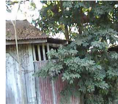
Fotografía 130 vista del Taller de maquinaria y Mantenimiento en la Estación Patulul)
