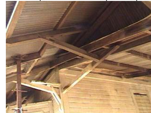
Fotografía 100 otro lado de la estructura portante del techo edificio 1.
