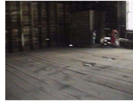
Fotografía 87 vista del interior de la estación edificio 1.
