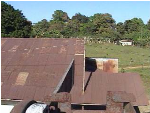
Fotografía 103 vista aérea de la estructura de la cubierta del edificio 1.
