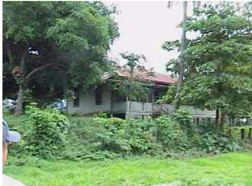
Fotografía 110 se aprecia la vista perspectivada lateral izquierda y frontal de la vivienda del telegrafista (edificio 3).
