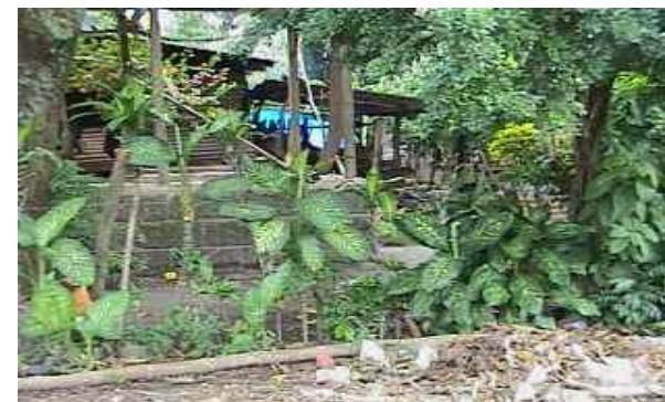
Fotografía 108 se aprecia la vista lateral derecha de la plataforma del que fue el Hotel de la estación de Patulul. (Edificio 2)
