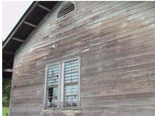
Fotografía 96 vista posterior de edificio 1.
