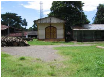
Fotografía 139 , Edificio de la Iglesia de la Hacienda Cocales
