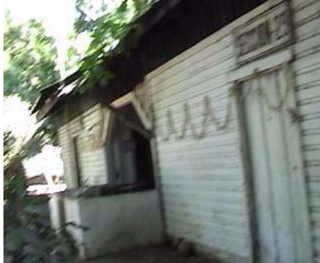
Fotografía 124 Vista frontal del modulo habitacional o jefe de cuadrilla sección 29
