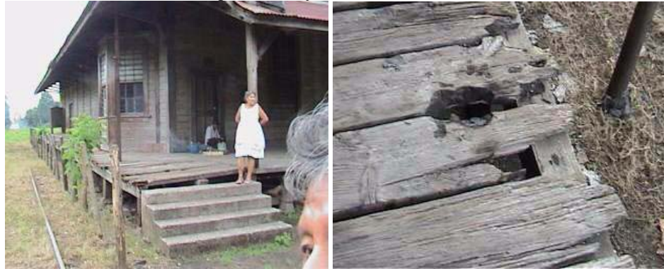
Fotografía 84 vista lateral y frontal edificio 1. Fotografía 85 vista lateral derecha del pasillo edificio 1.
