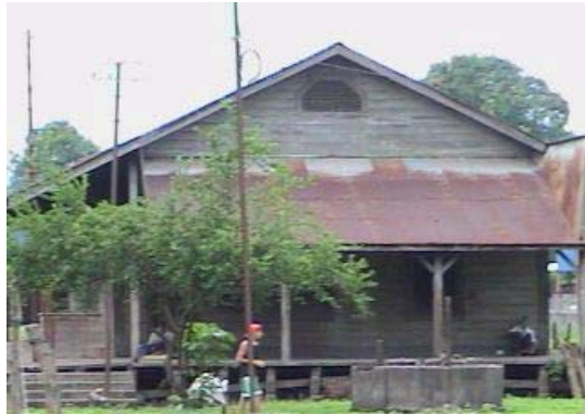
Fotografía 98 vista frontal del edificio 1.
