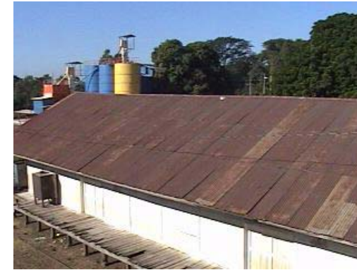
Fotografía 104 vista exterior del techo lado izquierda del edificio 1.
