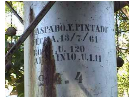
Fotografía 71 Se aprecia la marca del tanque y la fecha en que fue raspado y pintado.
