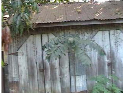
Fotografía 128 vista principal del Taller de Mantenimiento de la estación Patulul.
