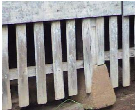
Fotografía 116 se aprecia la vista del cerramiento existente de recubrimiento de los pilotes vivienda del telegrafista (edificio 3).
