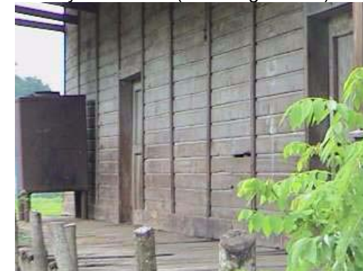
Fotografía 97 vista lateral izquierda edificio 1.
