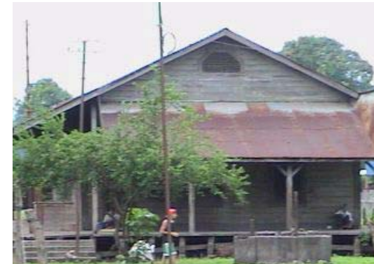
Fotografía 80, Fachada principal de la Estación de Patulul, Octubre 2003.
