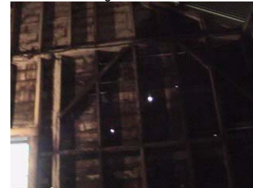
Fotografía 94 interior de edificio 1 separación de Párales.
