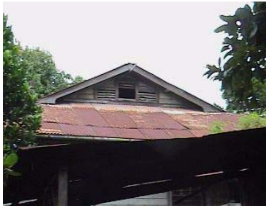
Fotografía 113 vista lateral derecha de la vivienda del telegrafista en la Estación Patulul (edificio 3).
