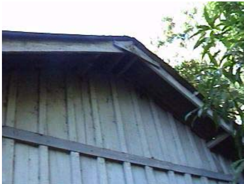
Fotografía 126 vista lateral derecha del modulo habitacional jefe de cuadrilla sección 29 edificio 4.
