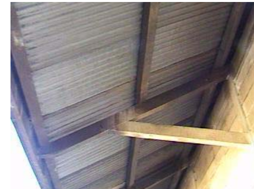
Fotografía 101 detalle de voladizo lateral del edificio 1.
