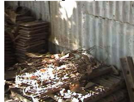
Fotografía 131 se aprecia partes de la vía férrea y de materiales que se utilizaban en la Estación de Patulul apilados a la par del edificio del taller de Mantenimiento.
