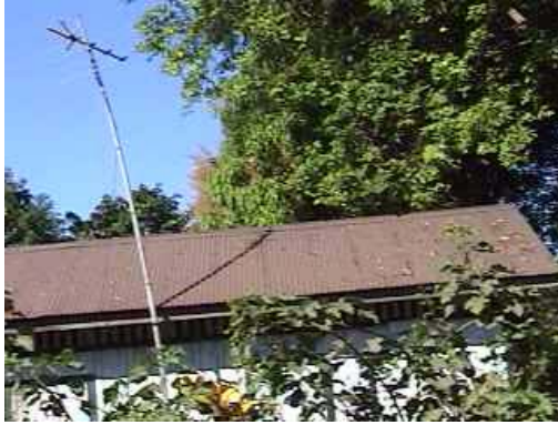
Fotografía 136 se aprecia el techo del modulo habitacional de la cuadrilla en la estación Patulul.
