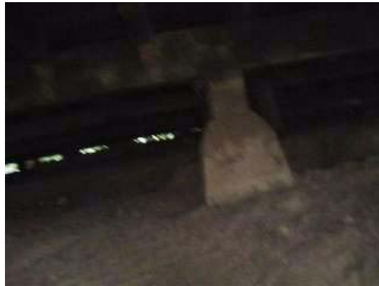
Fotografía 115 vista de los cimientos de pilotes que conforman la vivienda del telégrafista estación Patulul (vivienda 3).
