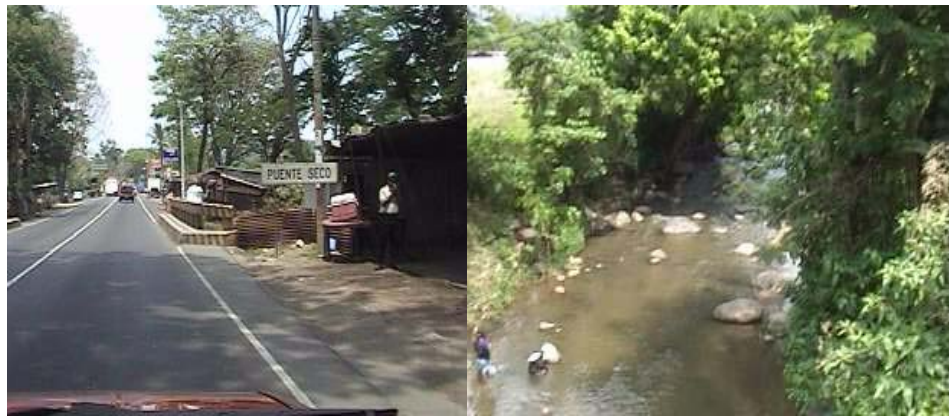
Fotografía 40 del puente del Río Seco ubicado metros del casco urbano de Cocales, abril 2004. Fotografías 41 Río Seco ubicado a pocos metros del casco urbano de Cocales, abril 2004.
