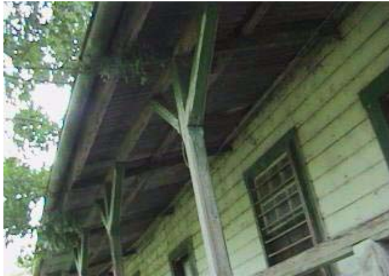
Fotografía 112 vista lateral izquierda de la vivienda del telegrafista Estación Patulul (edificio 3).
