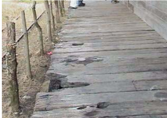
Fotografía 86 vista lateral izquierda del pasillo edificio 1.
