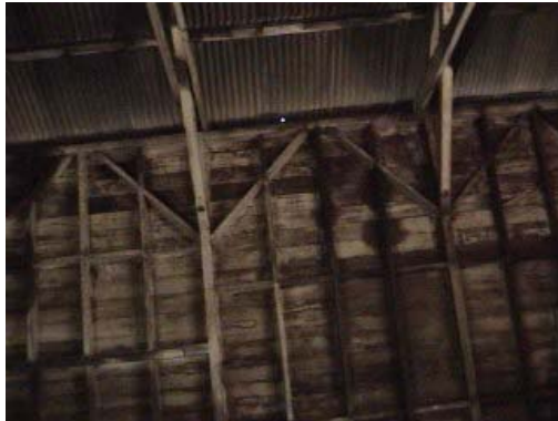
Fotografía 92 interiores de Edificio 1.
