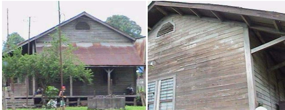
Fotografía 88 vista frontal de la estación edificio 1 Fotografía 89 vista posterior de edificio 1.
