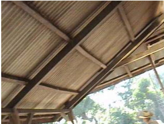
Fotografía 106 otra vista del voladizo en la parte frontal del edificio 1.
