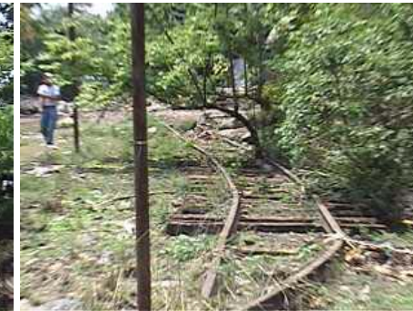
Fotografía 169, Asentamiento San Fernando
