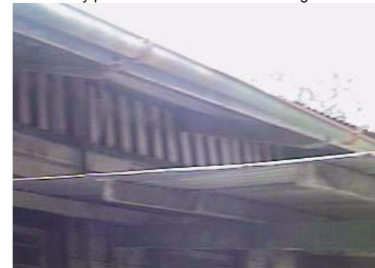
Fotografía 122 vista lateral derecha de la vivienda del telegrafista en la Estación Patulul (edificio 3).
