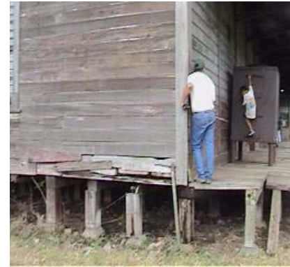
Fotografía 81 Vista lateral derecha y posterior edificio 1.
