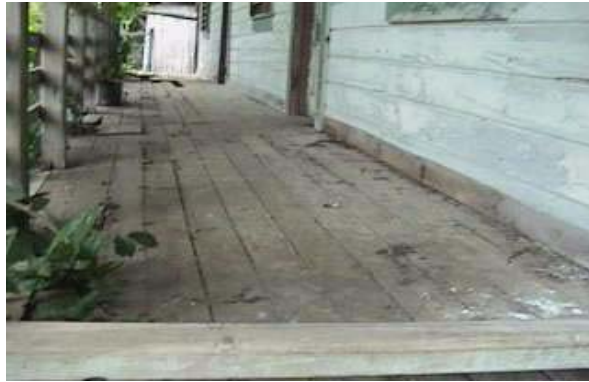
Fotografía 119 vista posterior del pasillo de la vivienda del telegrafista en la Estación Patulul (edificio 3).
