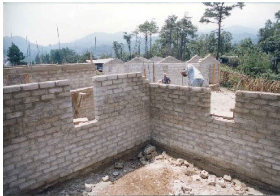
Vista panorámica de las viviendas en construcción.
