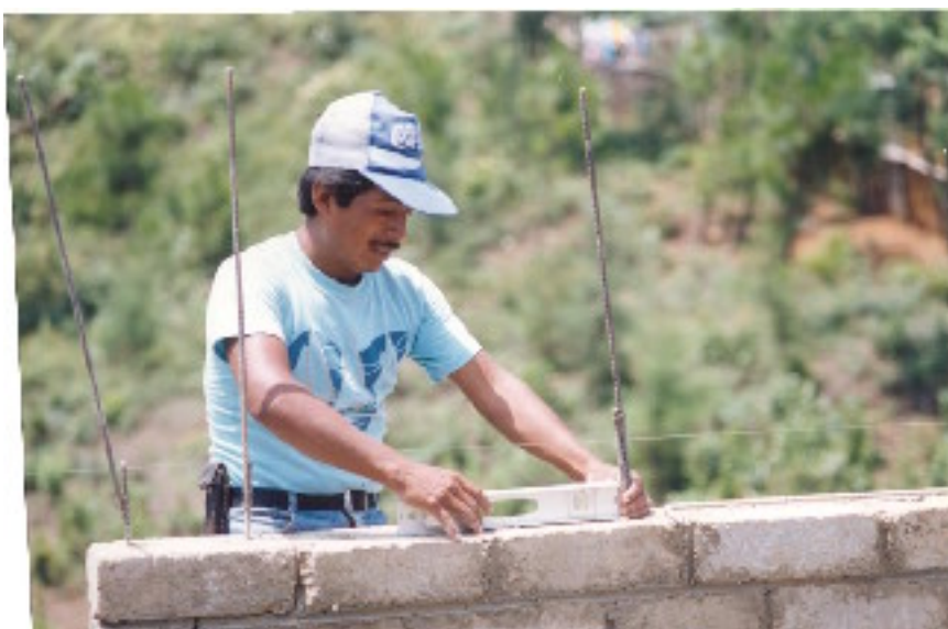
Levantado de muro con los bloks de adobe.
