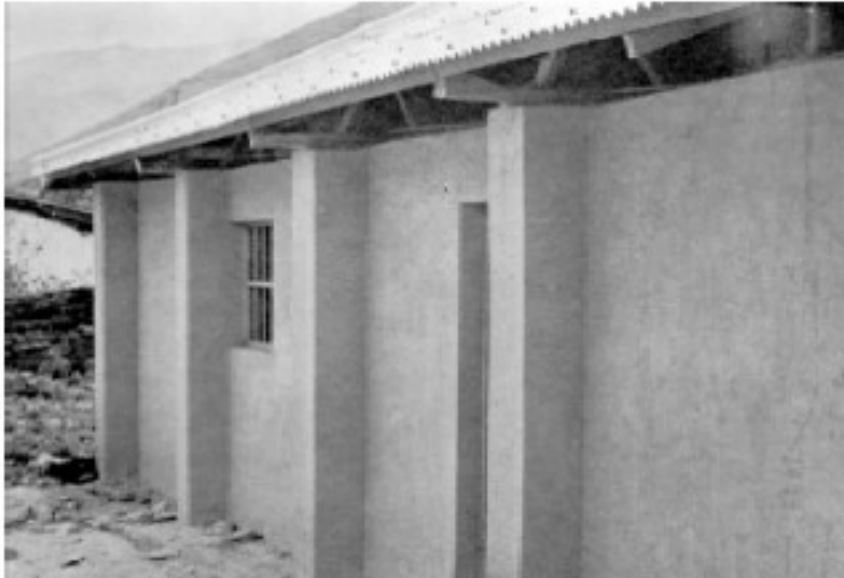
7-9 Diseño del sistema de adobes reforzados con centralizones
