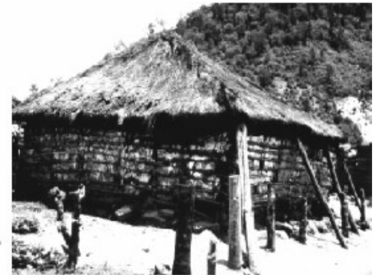
5-2 Vivienda de bahamuc en Guatemala por un sismo en Guatemala (Minke 2001)
