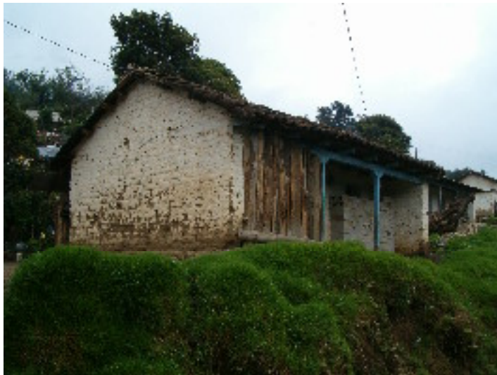
Vivienda en San José Chacayá, Sololá. Elaboración Propia.
