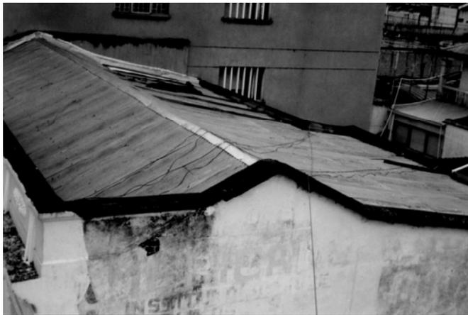
FOTO 1: Se muestra la cubierta del inmueble, observándose láminas en mal estado, así como humedad.
