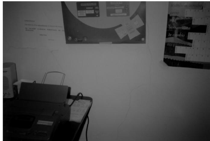
FOTO 4: Se observa una grieta que se desplaza por todo el muro.
