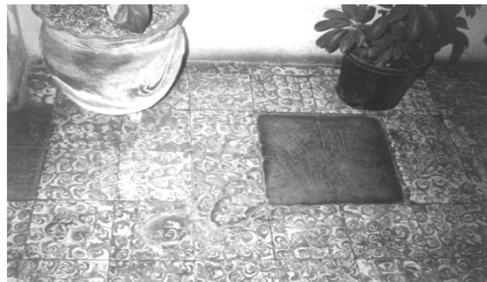
FOTO 6: Se muestra el mal estado del piso, así como algunas piezas faltantes.
