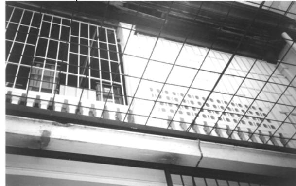
FOTO 2: Se observa la estructura, sobrepuesta en el patio, así como el mal estado de la madera del cielo falso.
