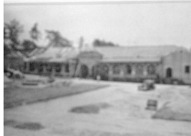
FOTOGRAFÍA No.34: VISTA DEL EDIFICIO DE LA POLICÍA, EN CONSTRUCCIÓN, AHORA EDIFICIO DEL INSTITUTO ADOLFO V. HALL. FOTOGRAFÍA TOMADA DEL ÁLBUM GRÁFICO, ADMINISTRACIÓN UBICO, TRABAJOS DE LA TESORERÍA NACIONAL, 1935.
