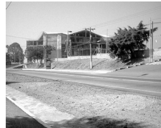
FOTOGRAFÍA No.45: PUEDE APRECIARSE LAS CONDICIONES EN QUE SE UBICA ESTE TRAMO DE LA AVENIDA DEL OBSERVATORIO, EL ASFALTO PUEDE VERSE Y TAMBIÉN LA TERRACERÍA Y EN LA PARTE INFERIOR IZQUIERDA UNA PARTE DE LA CUNETETA.
