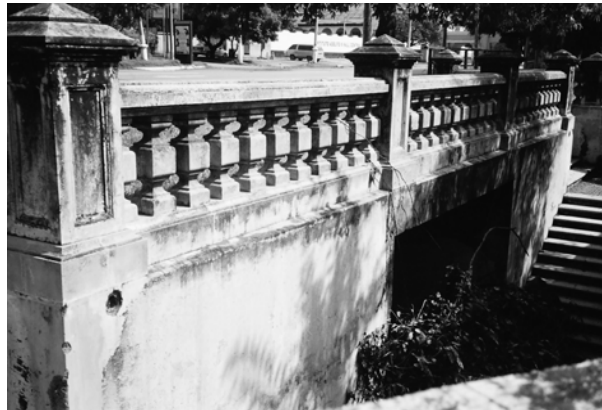
FOTOGRAFÍA No.80: VISTA DEL INGRESO A LA PASARELA SUBTERRÁNEA, REPRESENTANTE DE LA ARQUITECTURA NEOCLÁSICA.
