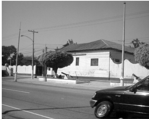
FOTOGRAFÍA No. 73: LA TENDENCIA HORIZONTAL SE MANIFIESTA EN LA AVENIDA DEL OBSERVATORIO, COMO PUEDE APRECIARSE EN LA VISTA DE LA FACHADA DEL INSTITUTO ADOLFO V. HALL CENTRAL
