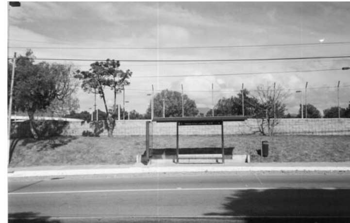
FOTOGRAFÍA No.72: BORDE CON PENETRACIÓN VISUAL, CONSTITUIDO POR ELEMENTOS TALES COMO, BLOCKS, CONCRETO REFORZADO, MALLAS Y TUBO GALVANIZADO.
