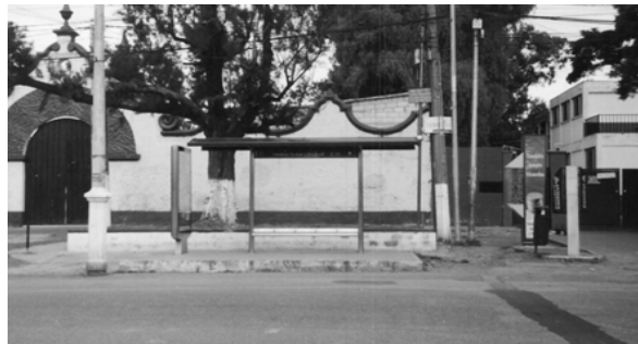
FOTOGRAFÍA No.46: PARADA DE BUS DEL INSTITUTO ADOLFO HALL.
