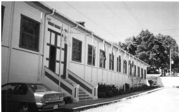
FOTOGRAFÍA No.75: PUEDE PERCIBIRSE EL RITMO ENTRE VANOS DE VENTANAS Y MACIZOS DE MUROS DEL SALÓN DE INDUSTRIAS No. 3, ACTUALMENTE OFICINAS DE ALBERGUE DEPORTIVO.
