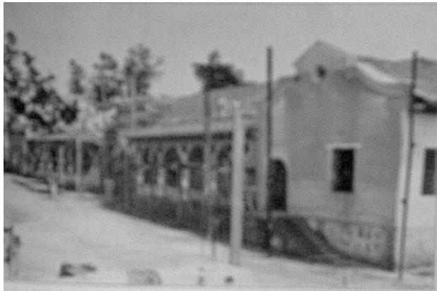
FOTOGRAFÍA No.35: VISTA DEL EDIFICIO DE LA POLICIA DE ORIENTE A PONIENTE.. TOMADA DEL ÁLBUM GRÁFICO, ADMINISTRACIÓN UBICO, TRABAJOS DE LA TESORERÍA NACIONAL, 1935.
