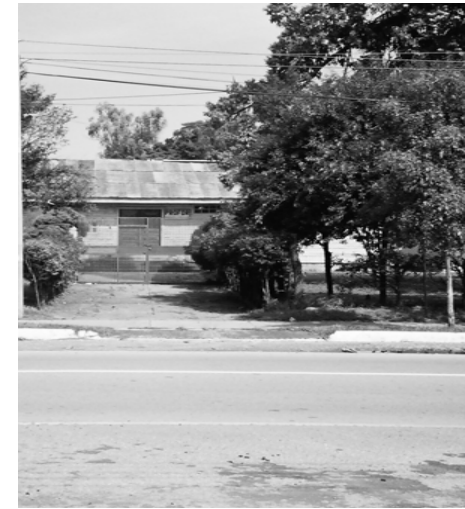
FOTOGRAFÍA No. 66: PUEDE OBSERVARSE LA INFLUENCIA DE CIUDAD JARDÍN, EN LA INTERRELACIÓN DE CONSTRUCCIONES CON LAS ÁREAS VERDES.
