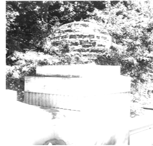
FOTOGRAFÍA No.53: DETERIORO DE ESFERA ORNAMENTAL (SERIAMENTE DAÑADA Y CON DESPRENDIMIENTOS DE LOS VIDRIOS QUE LA CONFORMABAN.)
