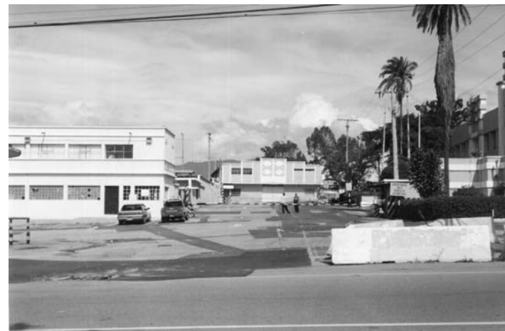
FOTOGRAFÍA No.77: EDIFICACIONES NO PATRIMONIALES CON RITMO IRREGULAR EN LOS VANOS DE LAS VENTANAS.
