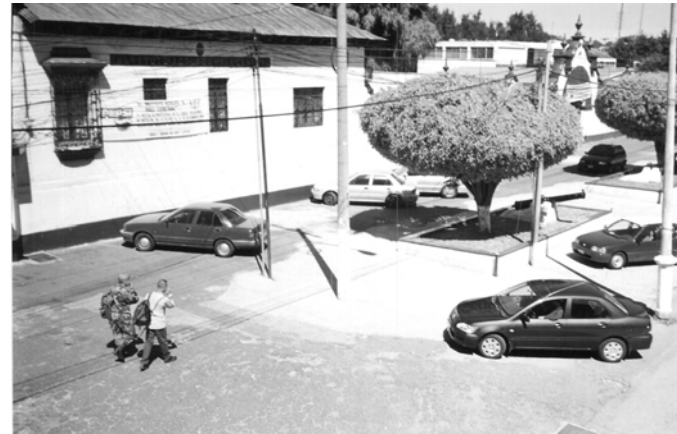
FOTOGRAFÍA No.76: EDIFICACIÓN PATRIMONIAL CON RITMO IRREGULAR EN LOS VANOS DE LAS VENTANAS DE LA FACHADA PRINCIPAL.
