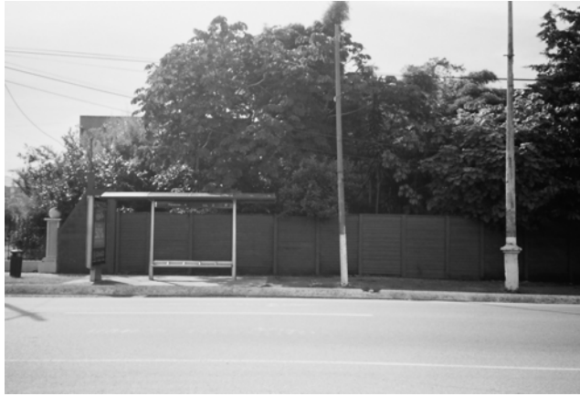
FOTOGRAFÍA No.83: OBSÉRVESE LA UTILIZACIÓN DE BARDAS PREFABRICADAS EN LOS MUROS EXTERIORES. ÁREA CORRESPONDIENTE AL MUSEO DE HISTORIA NATURAL..
