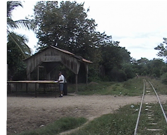
Vista exterior de la estructura.
