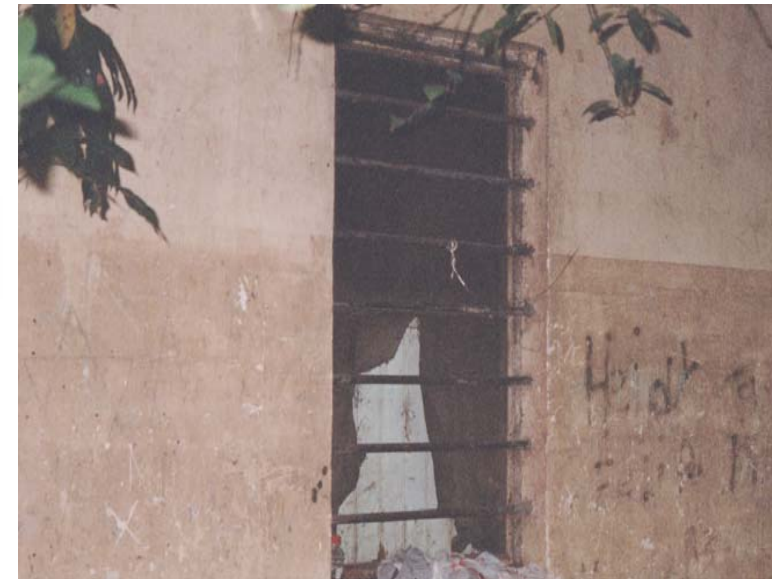
Ventana vista exterior de Anexo Cabañas, elevación lateral.
