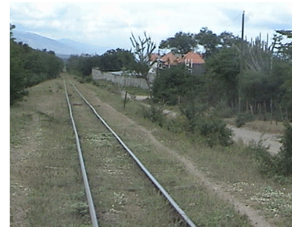
Foto No. 27 Estación de Bandera, en Mármol, Vista Oriente.
