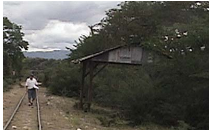
Vista Exterior de la Estructura.
