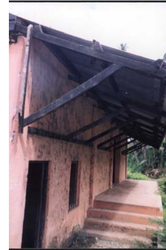
Foto No.35 Estación Cabañas. Vista Posterior.
