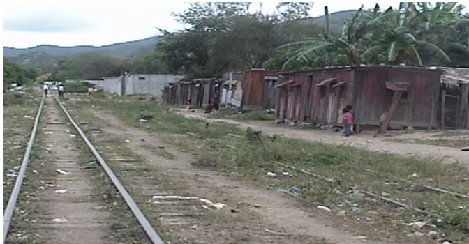
Foto No. 31 Invasiones de Familias y Muros Privados en el Derecho de Vía.
