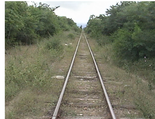
Foto No. 25 Estación de la Fragua Ubicación de Estación de Bandera, La Fragua. Fuente: Visita de Campo 2,004
