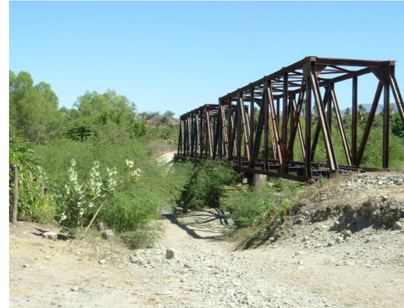
Foto No. 20 Vista del Puente El Tambor.
