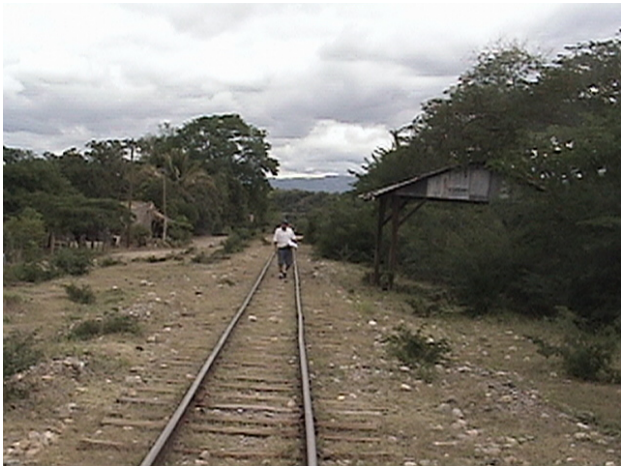
Vista exterior de la estructura.
