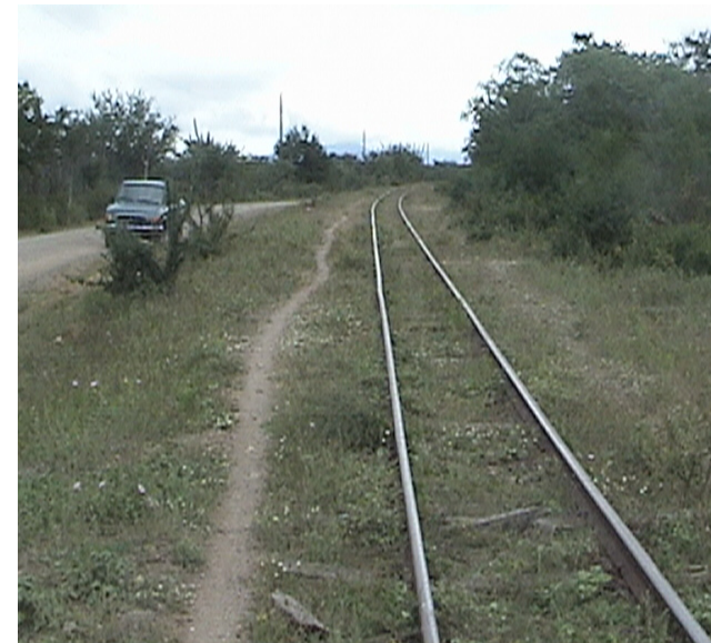
Foto No.28 Estación de Bandera Mármol. Vista Poniente.
