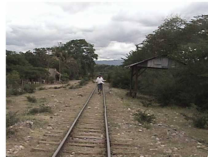
Foto No. 38 Estación El Tambor. Vista Poniente.
