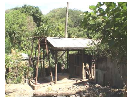
Fotografía No. 57 Vista de estructura antigua del depósito de agua.
