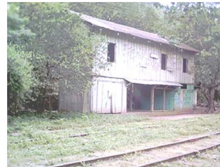
Fotografía No. 71 Vista Frontal Estación Cucajol.
