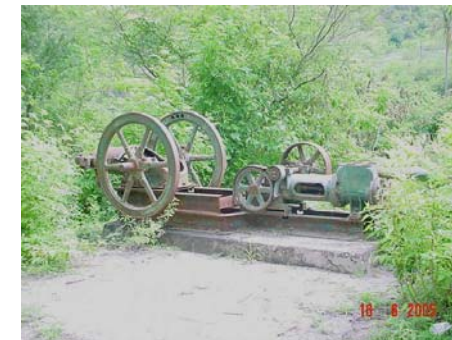
Fotografía No. 43 vista de los restos del motor de la bomba de agua.
