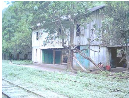
Fotografía No. 69 Vista Frontal Estación Cucajol.
