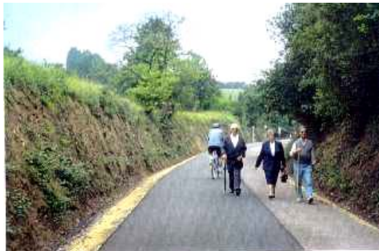
Foto No. 2 La solución de emplear diferente tipo de superficie para los caminantes y para los ciclistas facilita el multiuso, evitando conflictos entre los distintos usuarios (Vía Verde de La Camocha)
