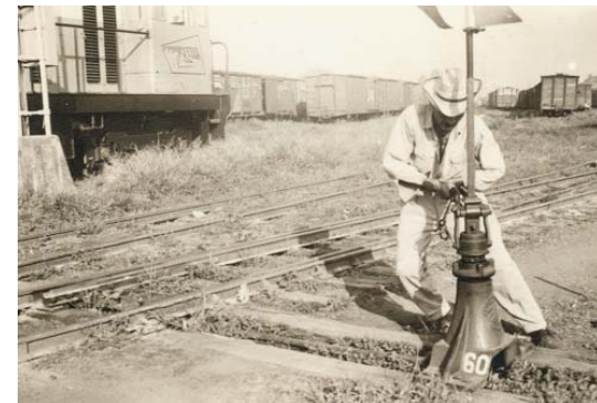
Fotografía No. 6 Una bandera para cambio de vía dentro del patio de maniobras de la Estación de Puerto Barrios. Fuente: Carlos Torres.
