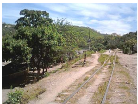
Fotografía No. 59 Vista nor.-Oeste
